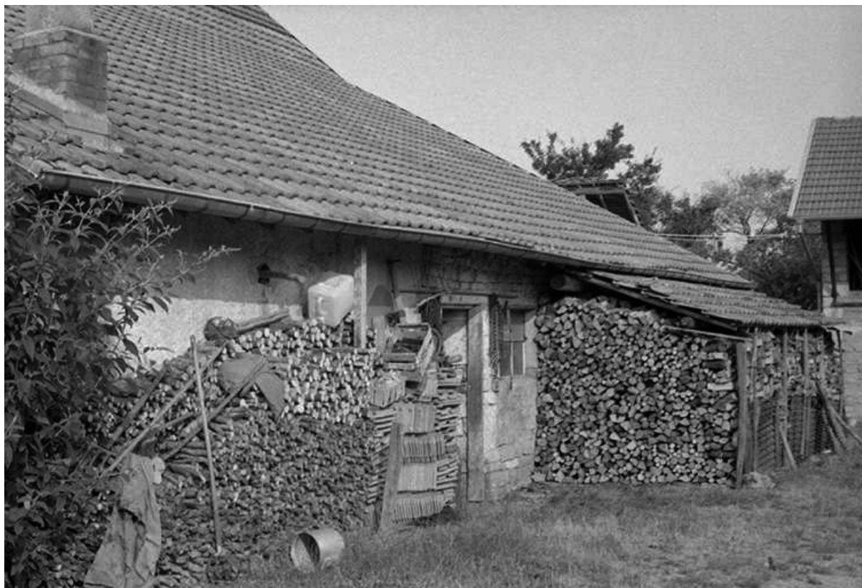
Façade latérale droite. 25, Tarcenay Grande Rue
