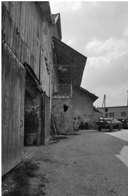
maison de vigneron : façades postérieure et latérale gauche. 25, Tarcenay
