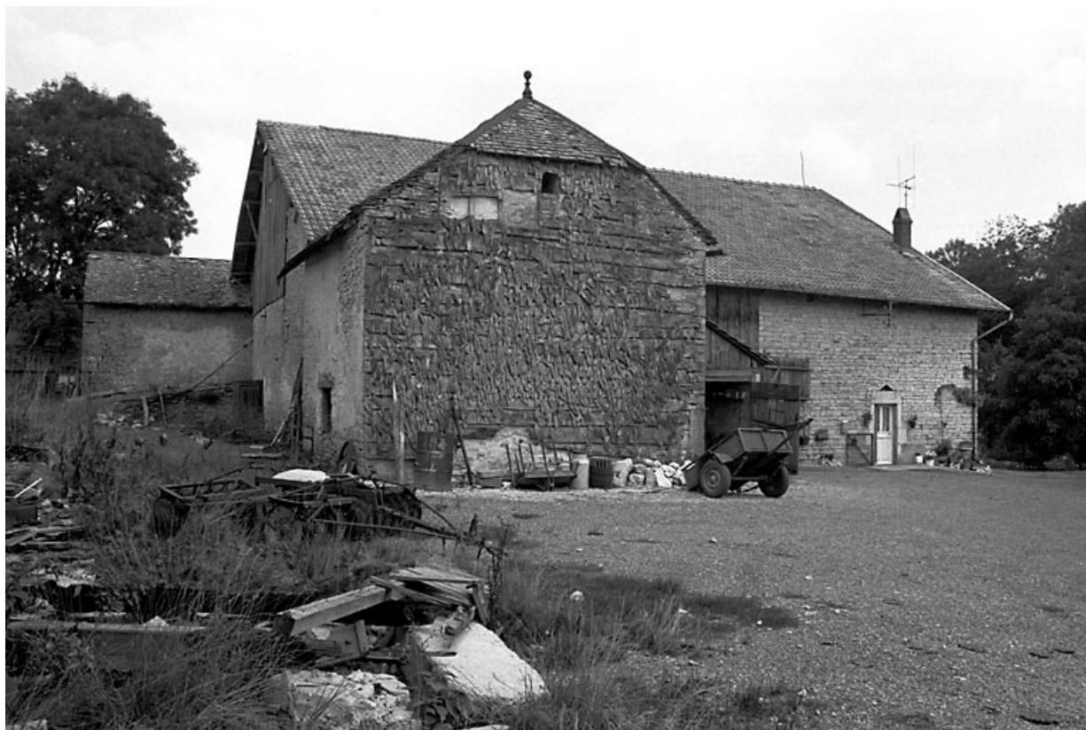
Vue générale depuis le sud-ouest.
