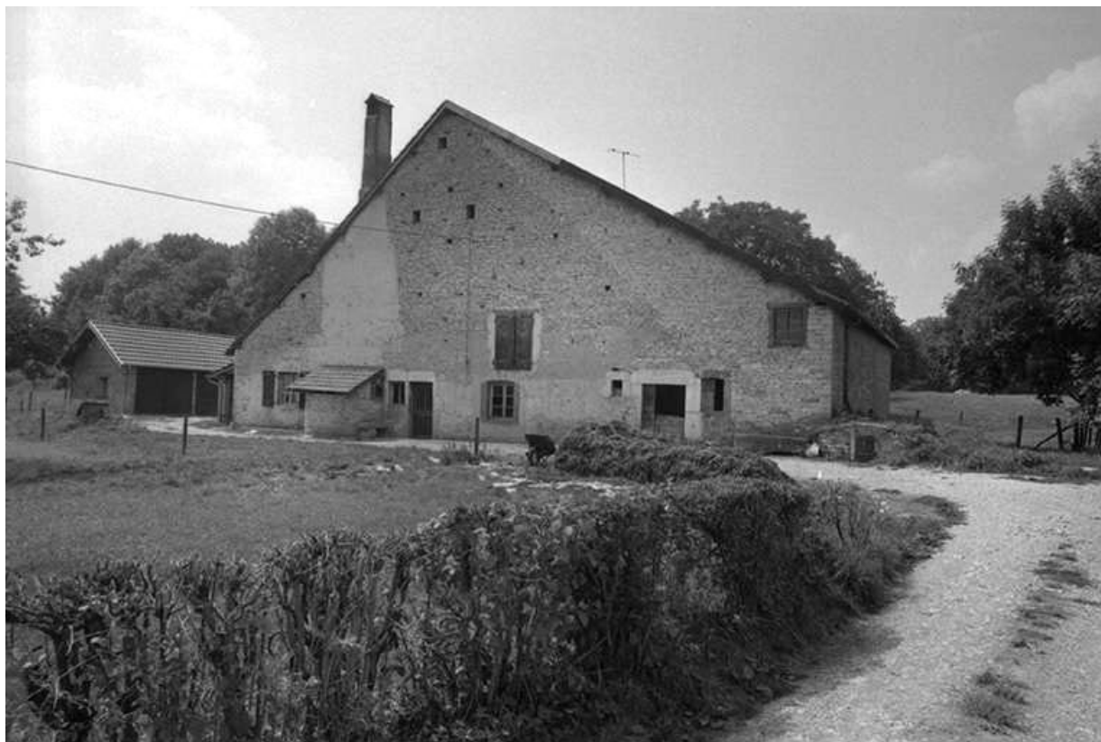
Ferme cadastrée 1965 ZL 137, située au lieu-dit les Cloutiers : vue générale. 25, Tarcenay, lieudit : les Fougères
