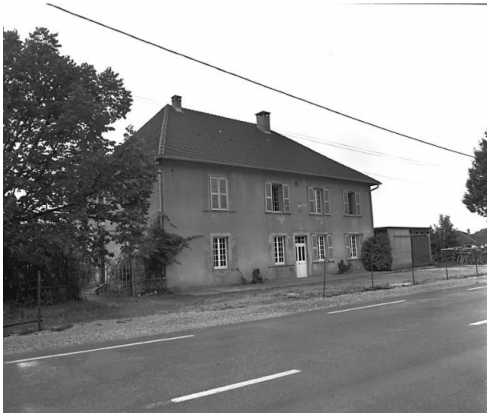
Façade antérieure vue de trois quarts gauche.
