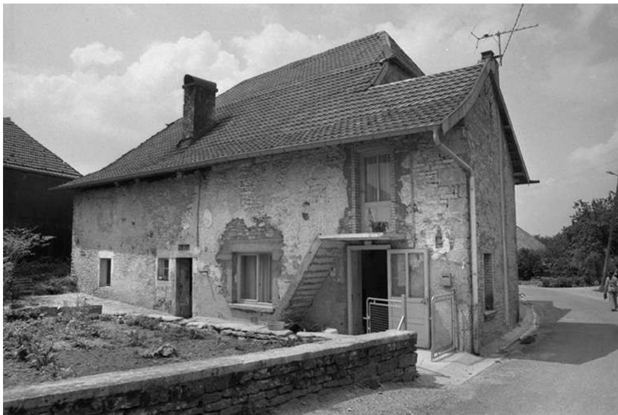
Ferme cadastrée 1965 ZM 103 : vue générale. 25, Tarcenay
