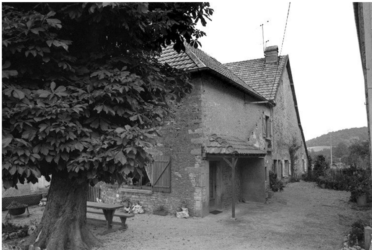
Ferme située 6 rue de Sous Velles : façade antérieure vue de trois quarts gauche. 25, Tarcenay
