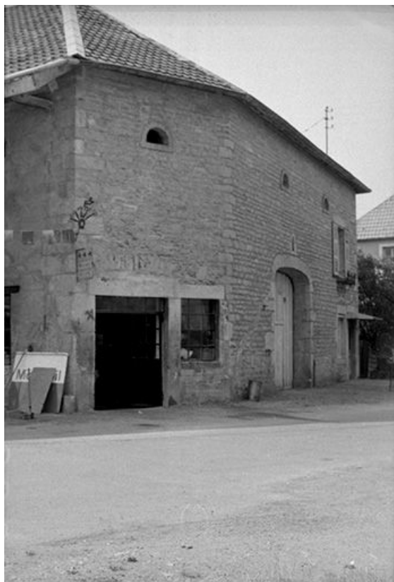
Ferme située Grande Rue, côté rue du Tilleul : façade antérieure. 25, Tarcenay
