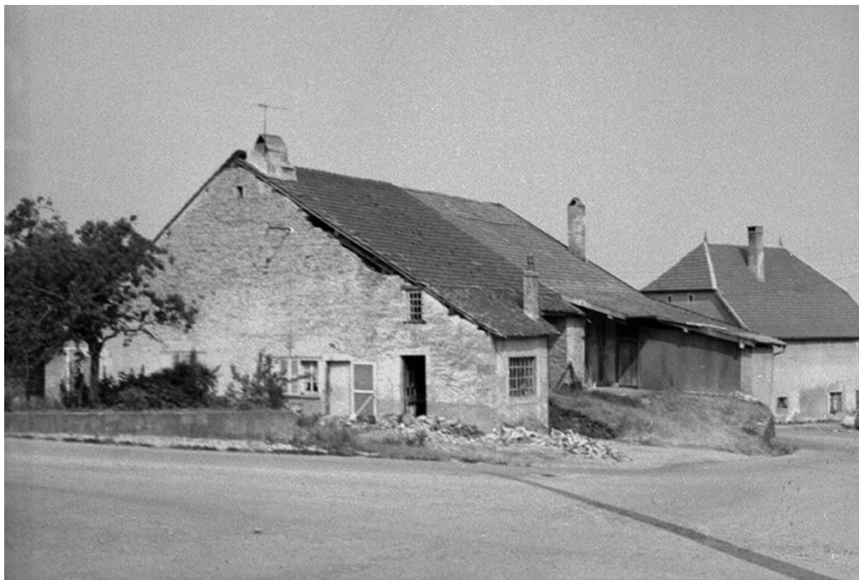
Ferme cadastrée 1965 ZM 95, située rue du Tilleul (?) : vue générale. 25, Tarcenay
