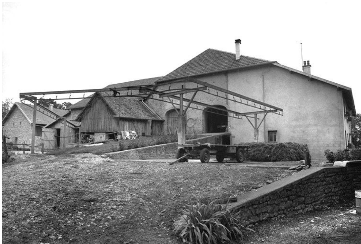
Ferme cadastrée 1965 ZL 69, située au lieudit Les Cloutiers : vue générale. 25, Tarcenay
