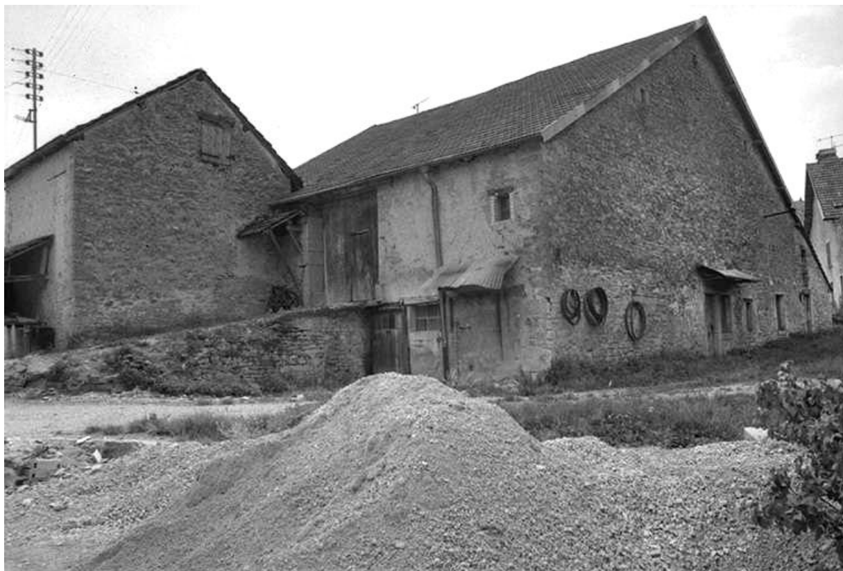
Ferme cadastrée 1965 ZM 102 : vue générale de trois quarts gauche. 25, Tarcenay
