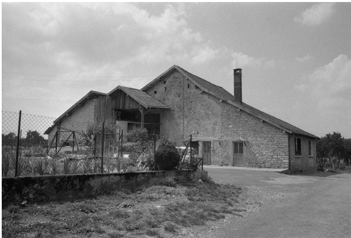
Ferme située 6 rue de Sous Velles : façade antérieure de trois quarts gauche. 25, Tarcenay
