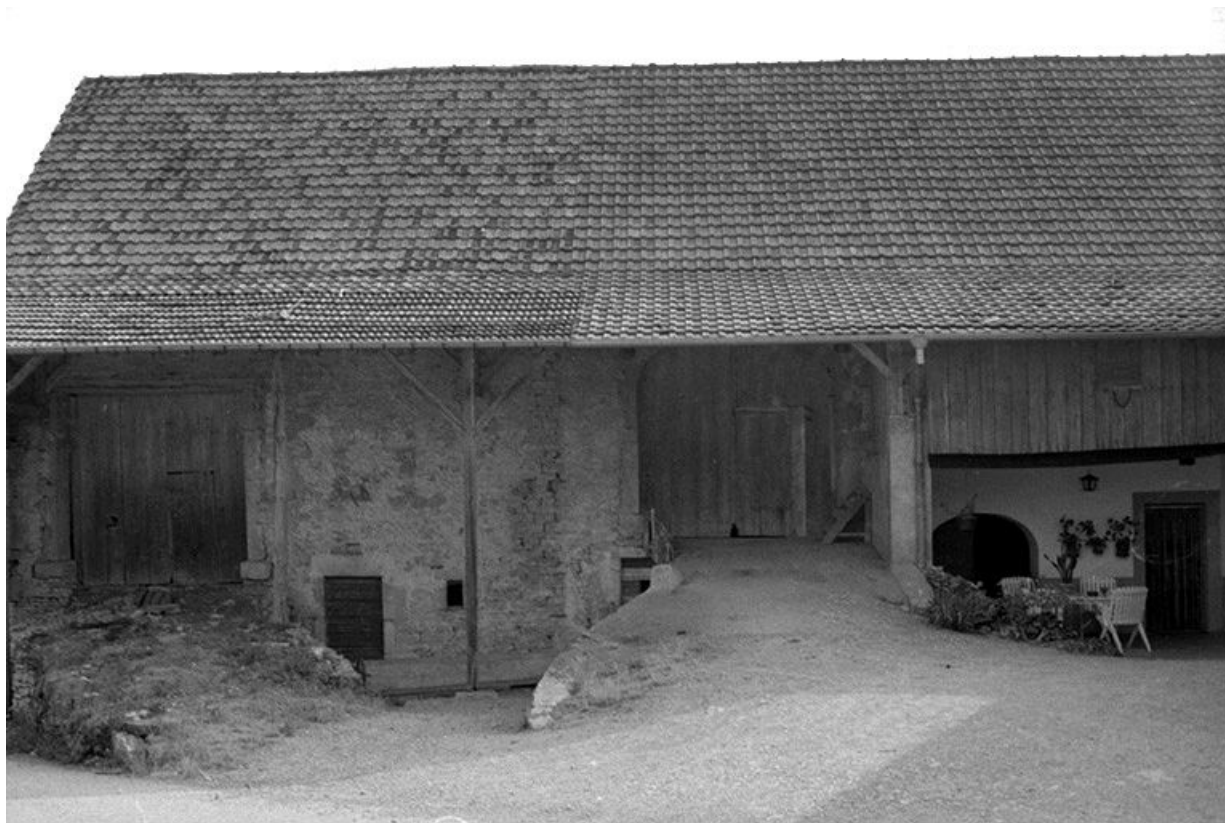
Ferme cadastrée 1965 ZM 23, située route de Besançon (?) : façade antérieure. 25, Tarcenay
