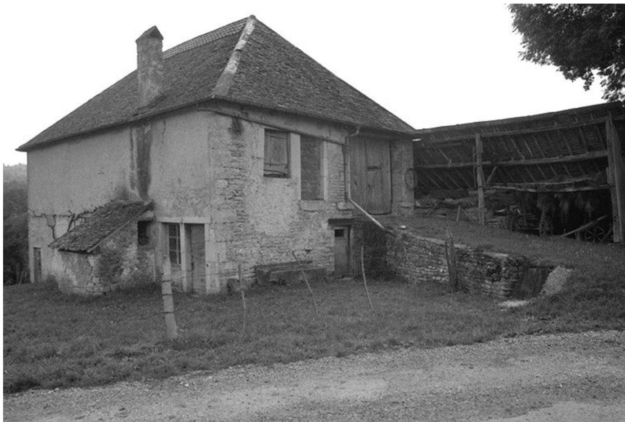
Ferme cadastrée 1965 ZL 67 située au lieu-dit les Cloutiers : vue générale. 25, Tarcenay
