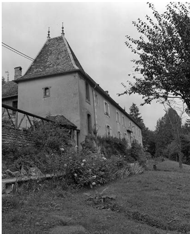
Façade antérieure vue de trois quarts gauche.
