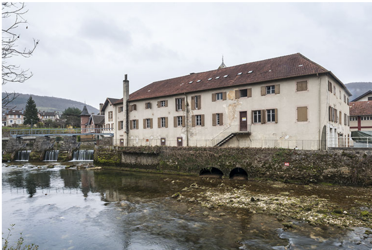
Façade nord du bâtiment du moulin.
