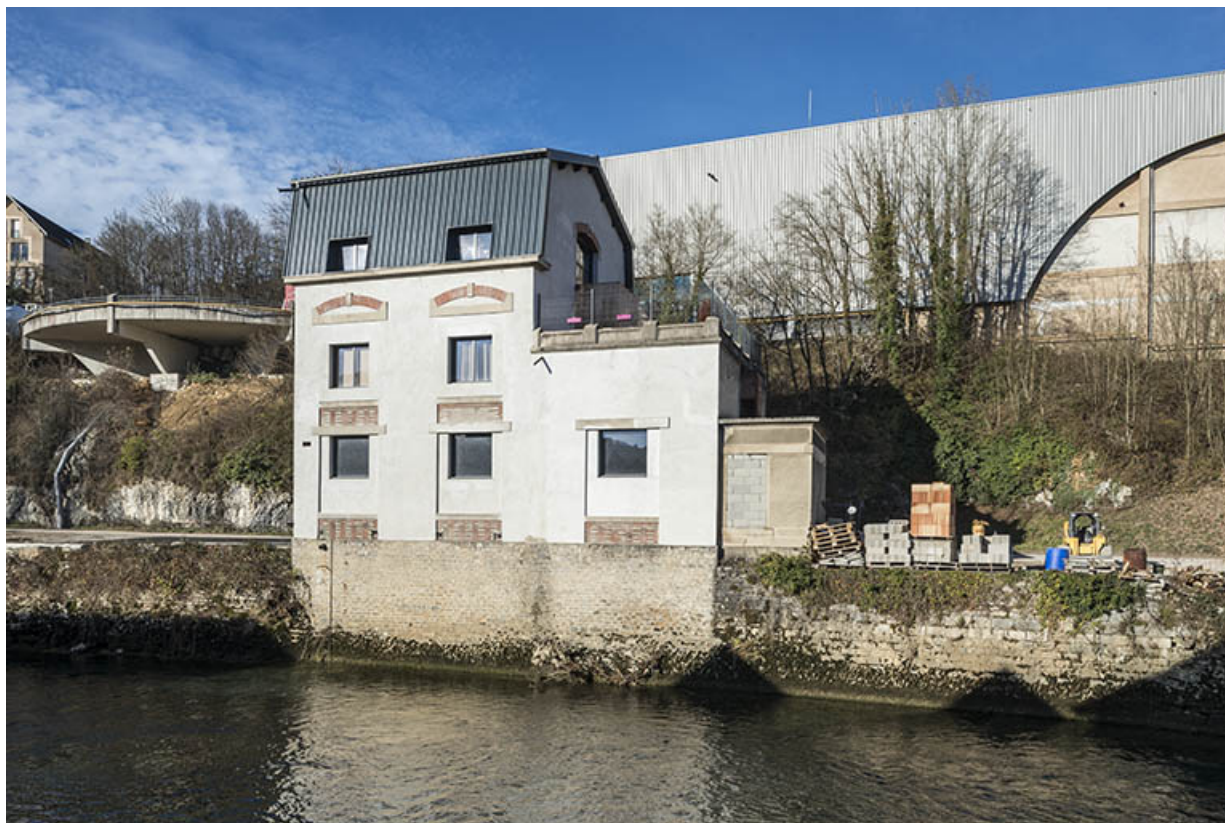
Transformateur. Façade sud.
