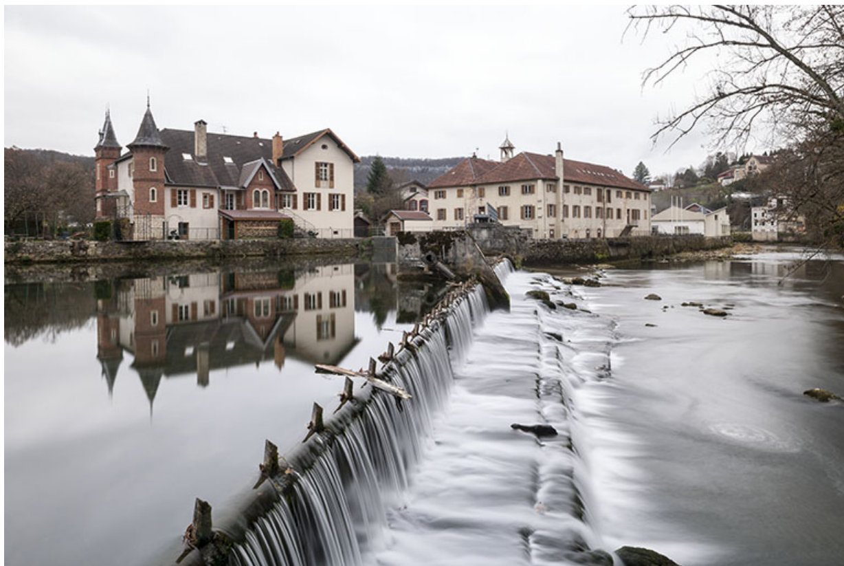
Vue d'ensemble depuis la rive droite du barrage.
