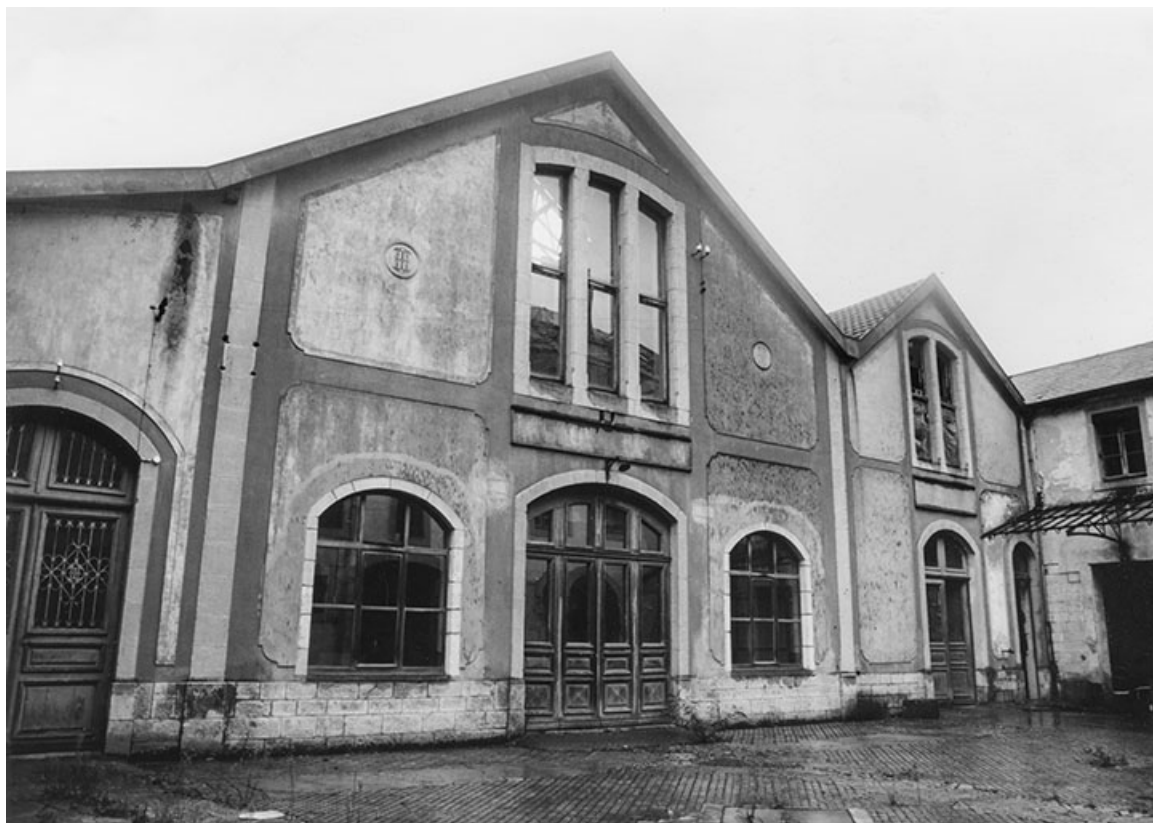
Façade antérieure de l'atelier de distillation, dit le laboratoire, en 2000.
