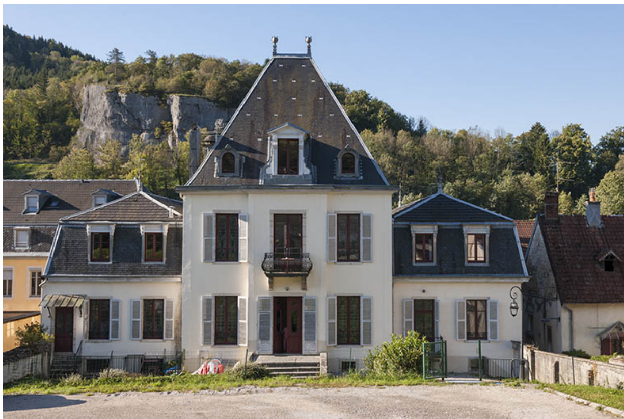
Façade postérieure du logement patronal. Vue de face.
