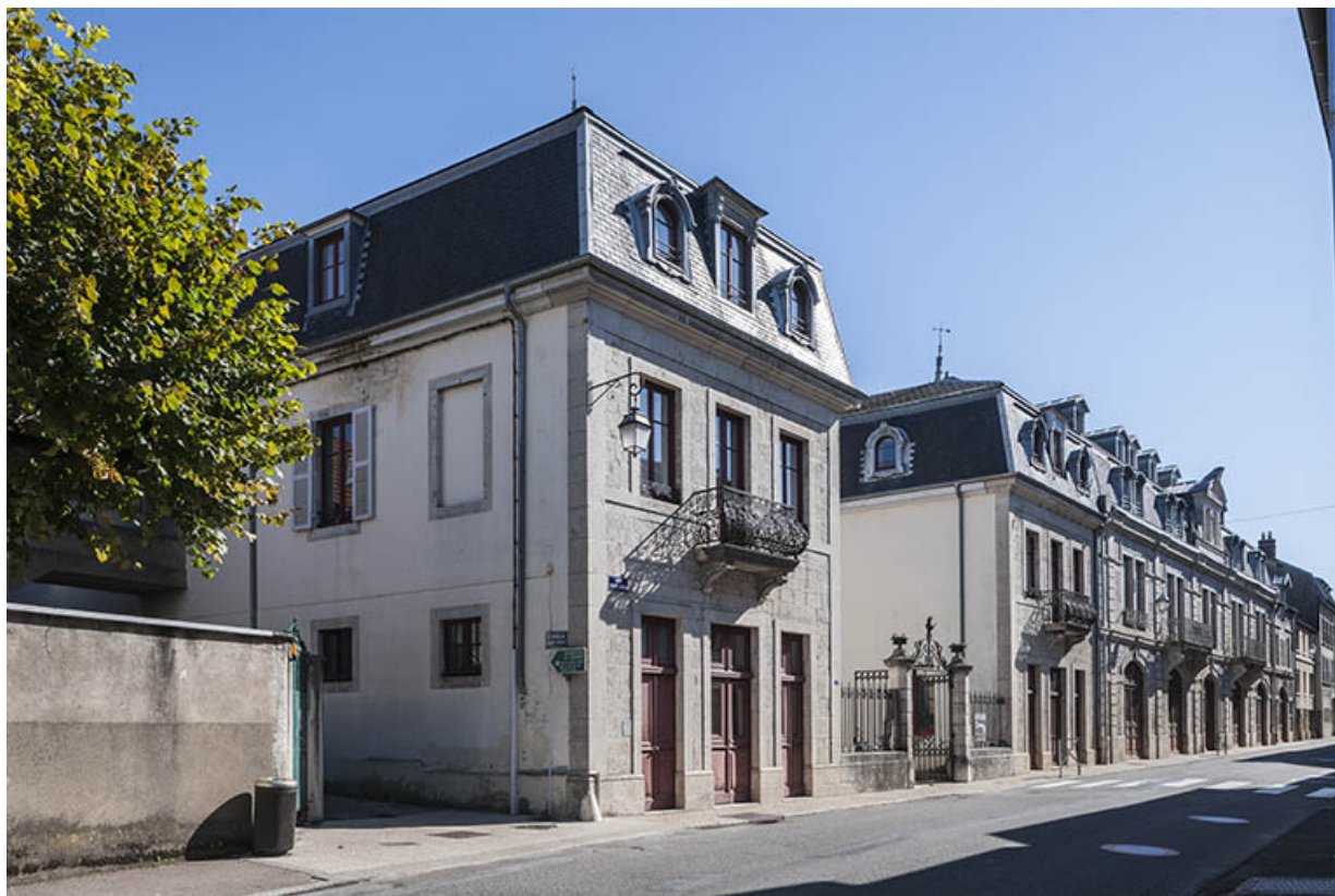
Vue d'ensemble et de trois quarts depuis la rue Cusenier.
