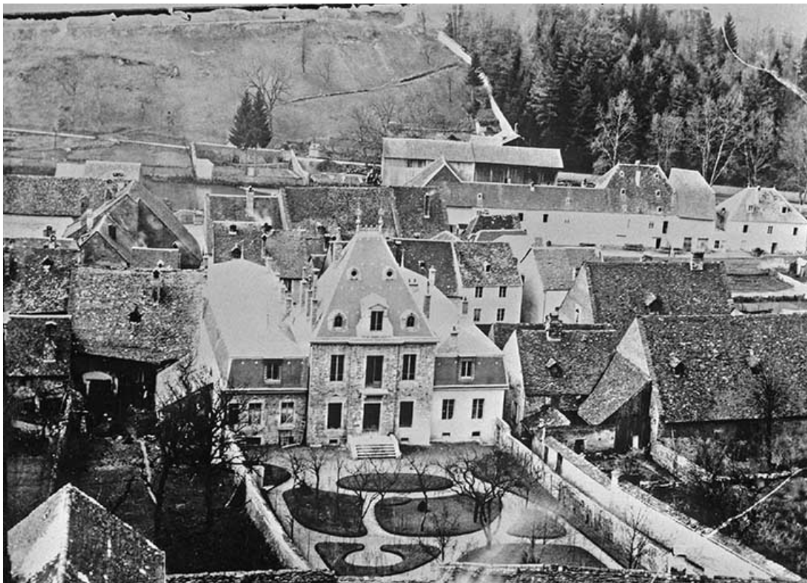
Façade postérieure du logement patronal et jardin d'agrément, vers 1880.
