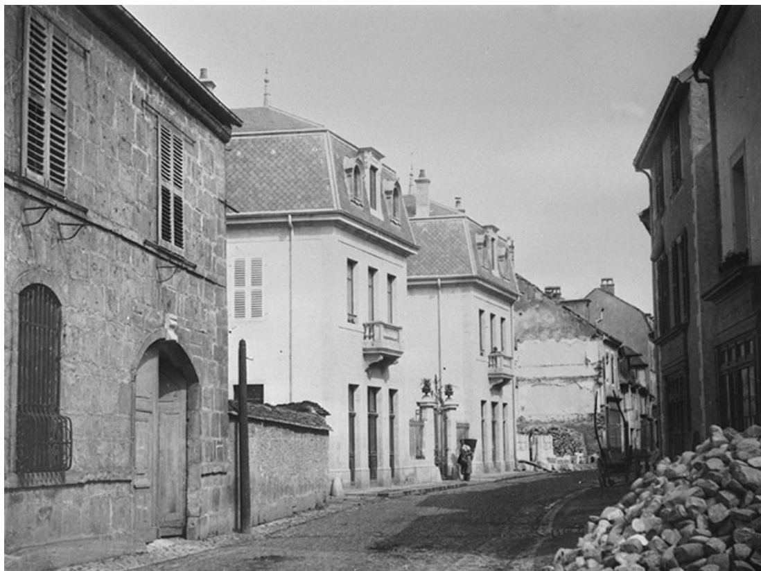
Façade antérieure du logement patronal, vers 1880.
