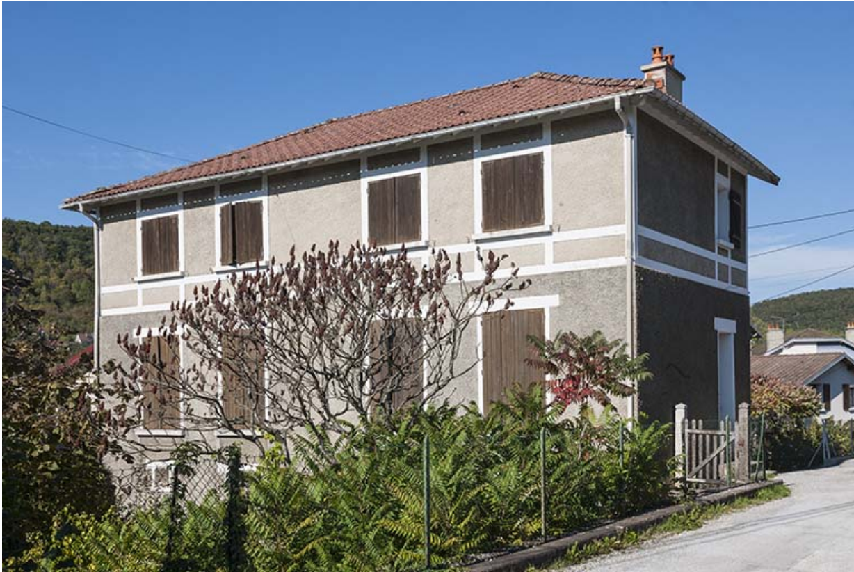
Façade postérieure d'une maison de célibataires.
