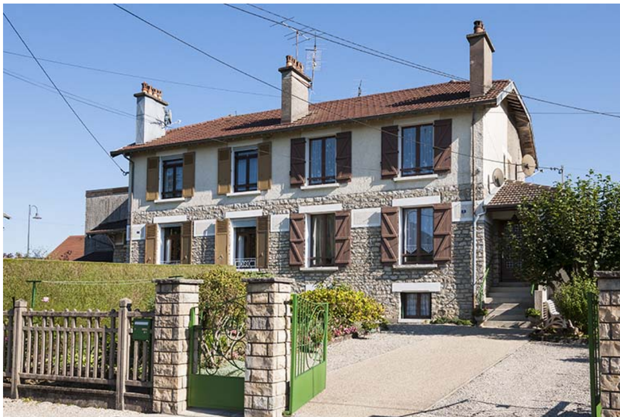
Façade antérieure d'une habitation à quatre logements.
