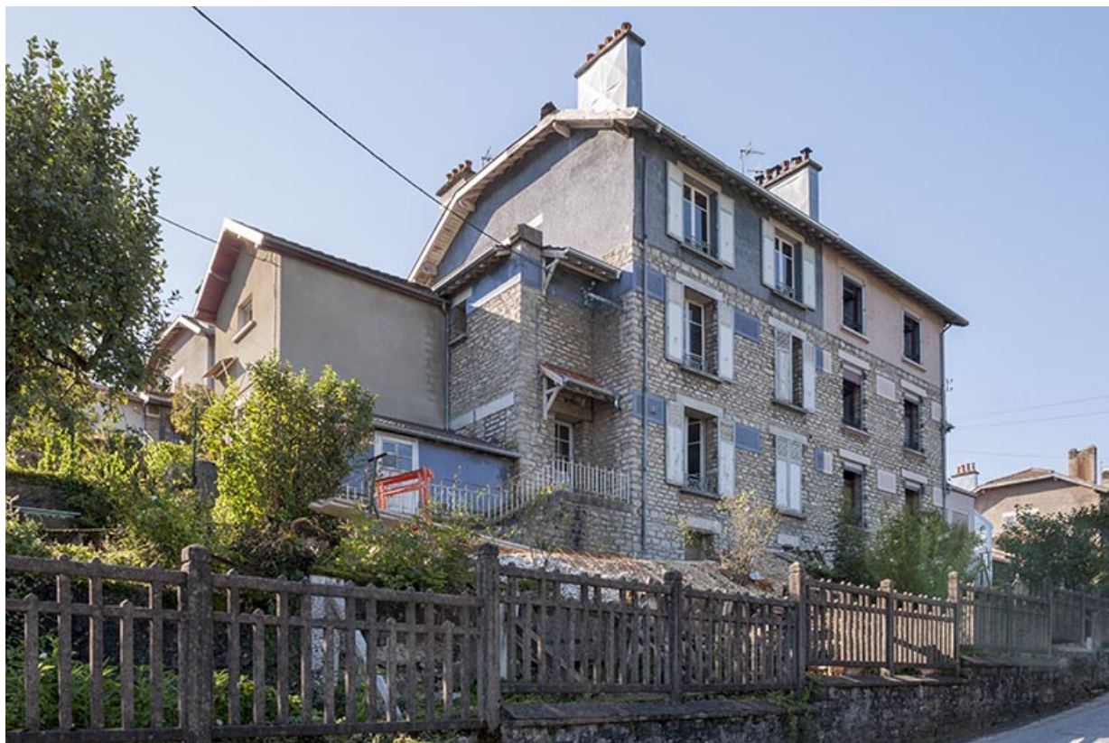
Façade nord d'une maison à quatre logements, avec deux étages de soubassement. 25, Ornans allée des Cités jardins Oerlikon
