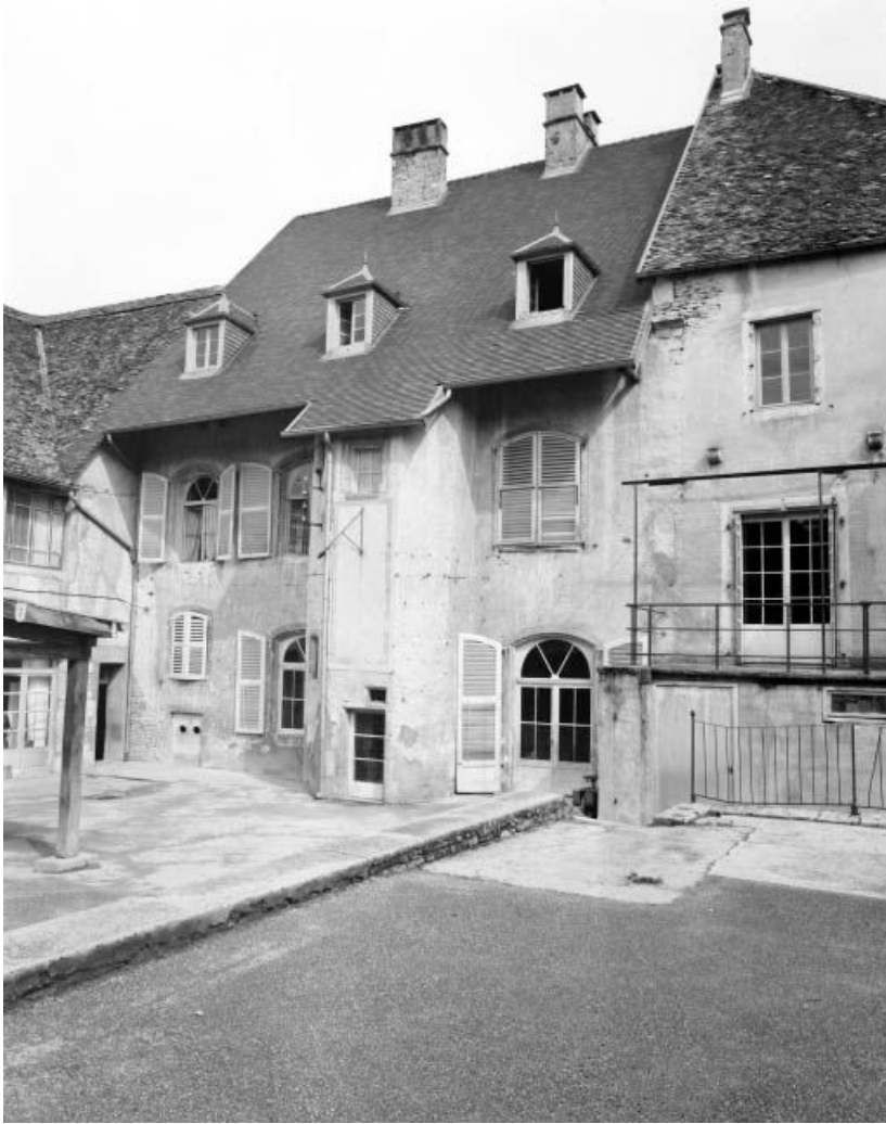
Façade postérieure, vue de trois quarts droit. 25, Ornans, 7 rue Saint-Laurent
