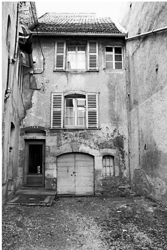
Façade antérieure sur cour.
