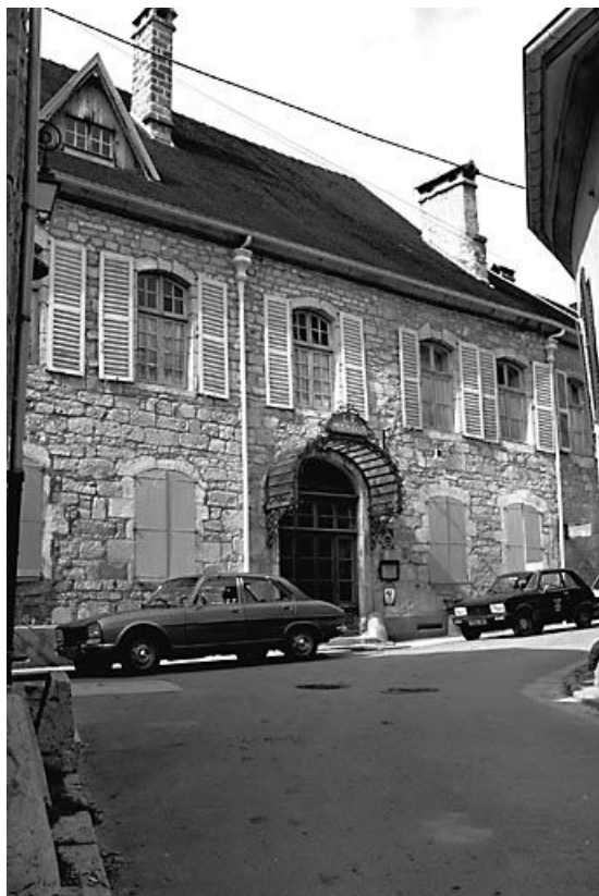
Façade antérieure vue de trois quarts gauche. 25, Mouthier-Haute-Pierre
