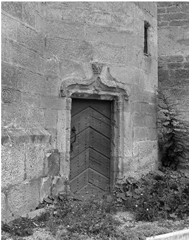
Détail de la tour-clocher : la porte conduisant à l'escalier.
