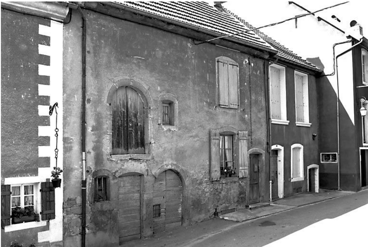
Façade antérieure vue de trois quarts gauche. 25, Mouthier-Haute-Pierre
