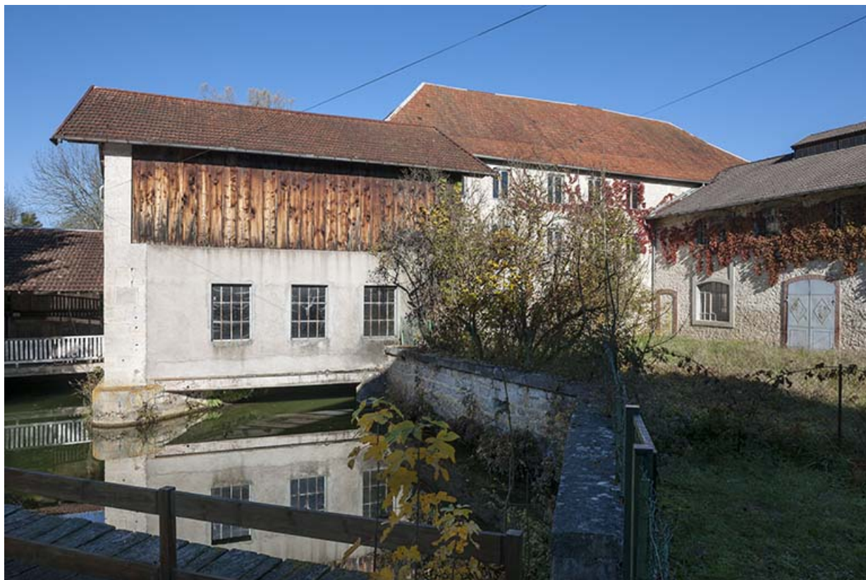
Bâtiment d'eau et atelier de fabrication.
