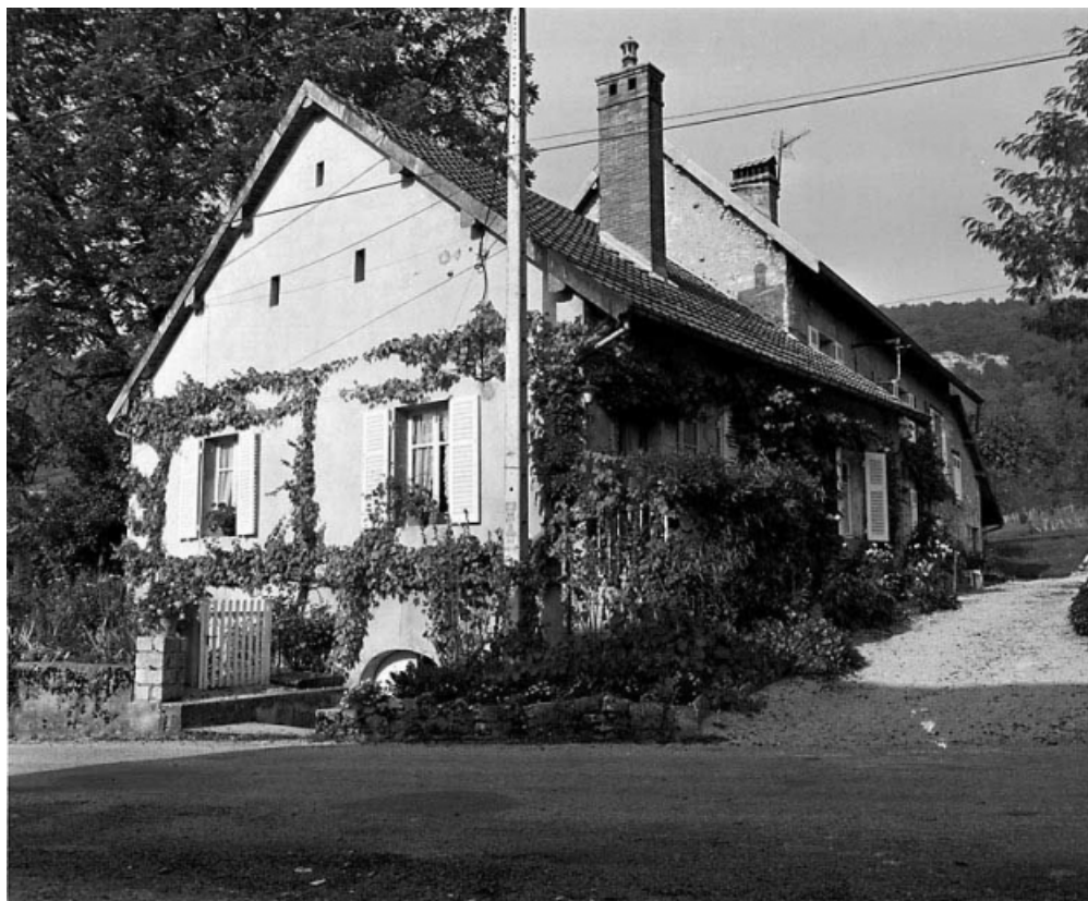
Façade antérieure et face latérale gauche. 25, Montgesoye
