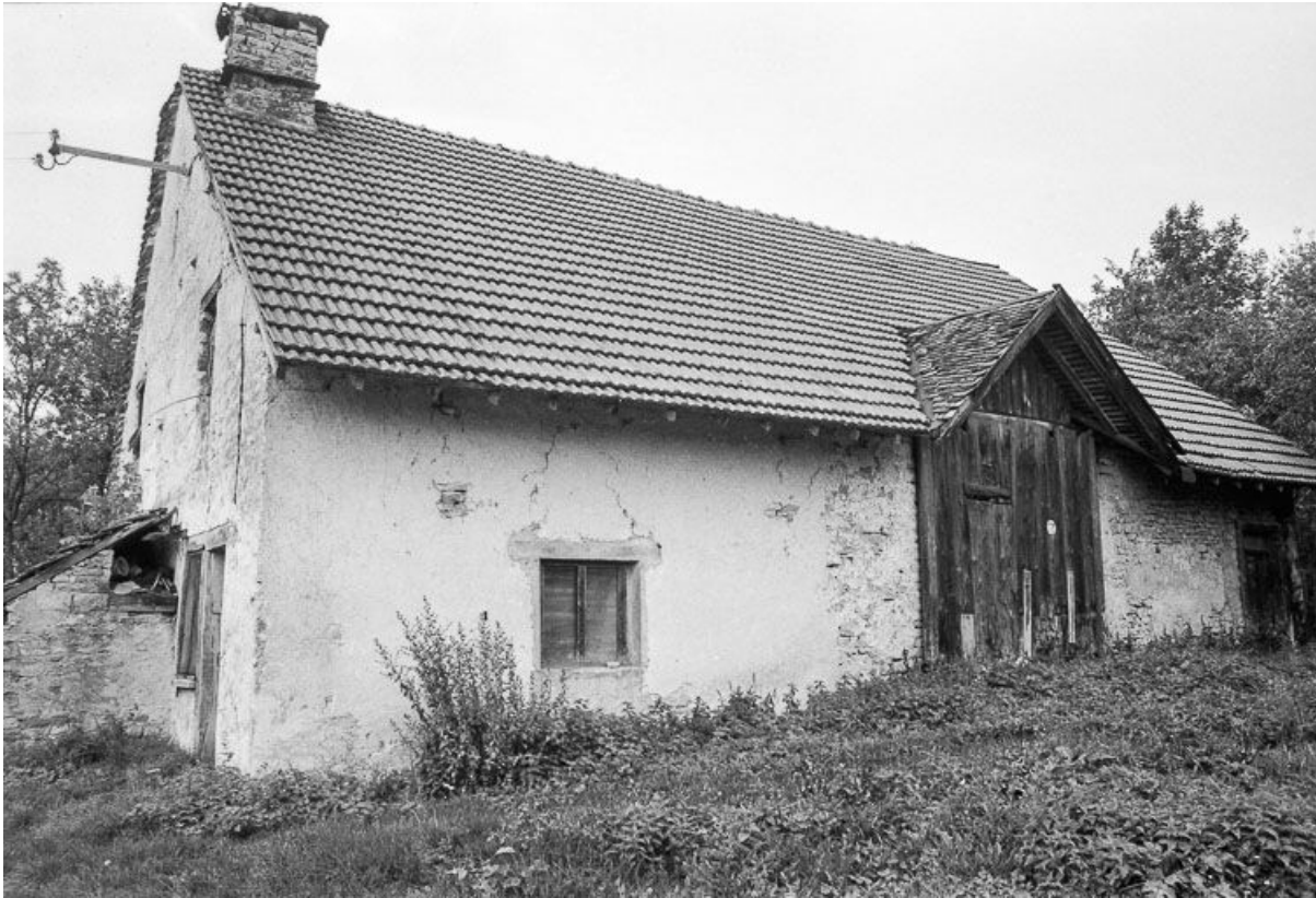
Façade latérale droite.
