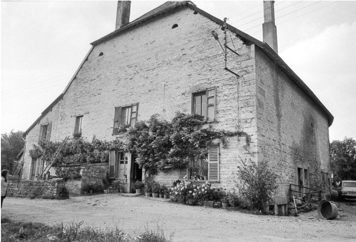
Façade antérieure. 25, Malbrans
