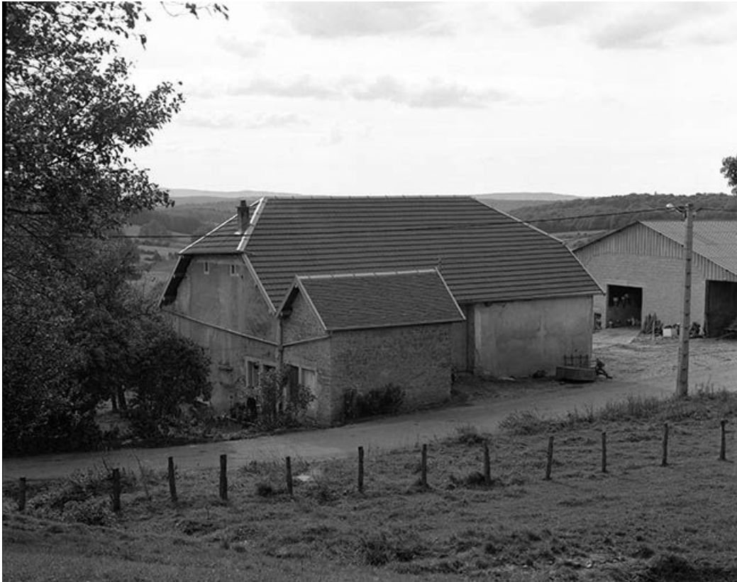
Façade antérieure et face latérale droite. 25, Malbrans
