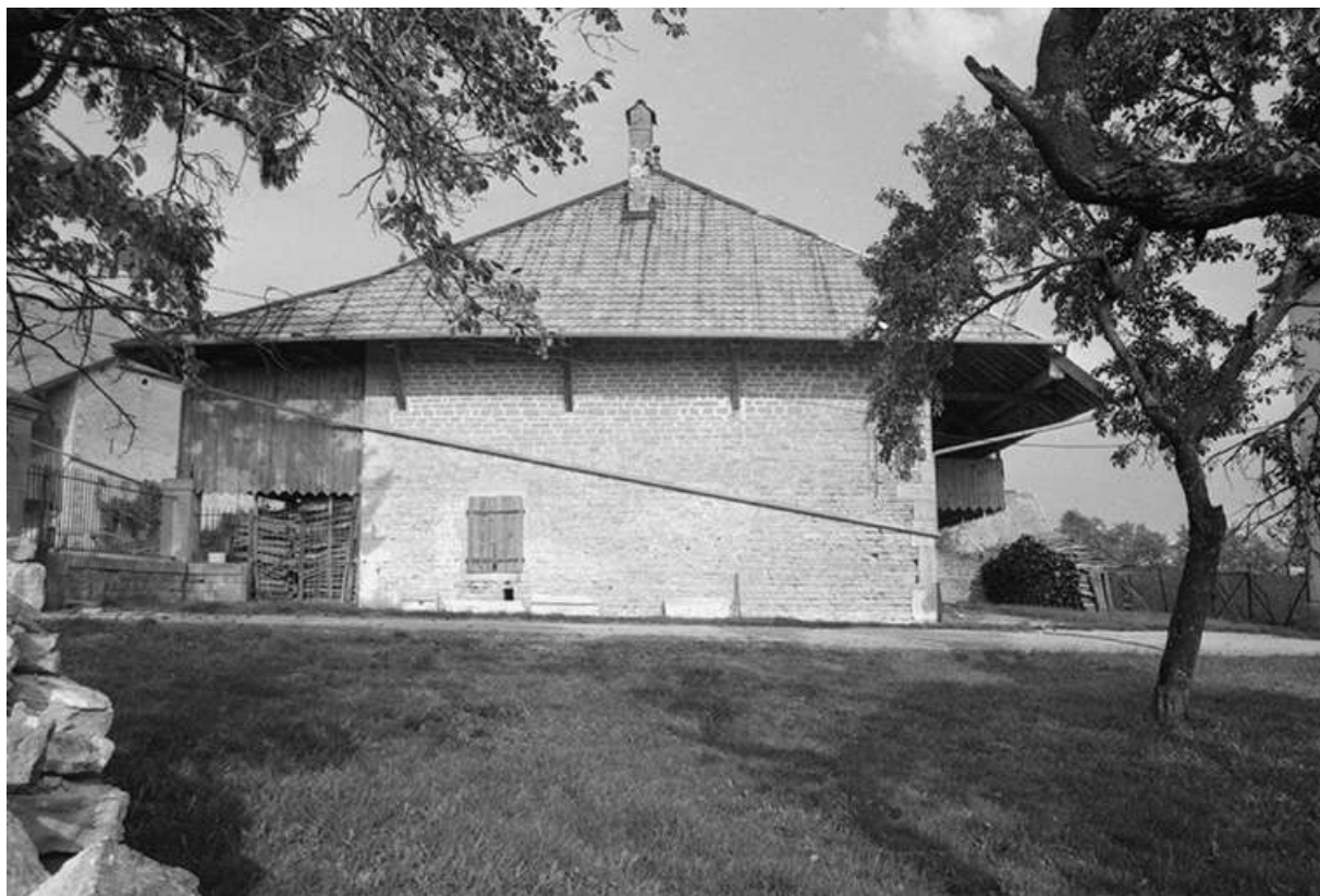
Façade latérale droite des parties agricoles.
