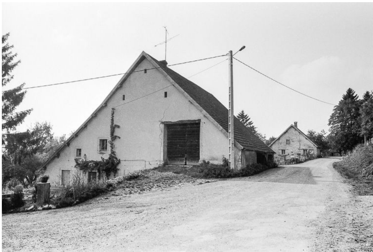
Ferme située rue de la Fontaine : vue générale. 25, Malbrans
