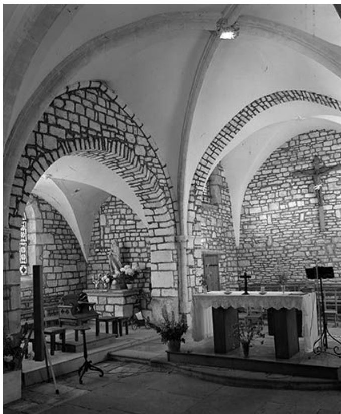
Intérieur : le chœur vu de trois quarts gauche.
