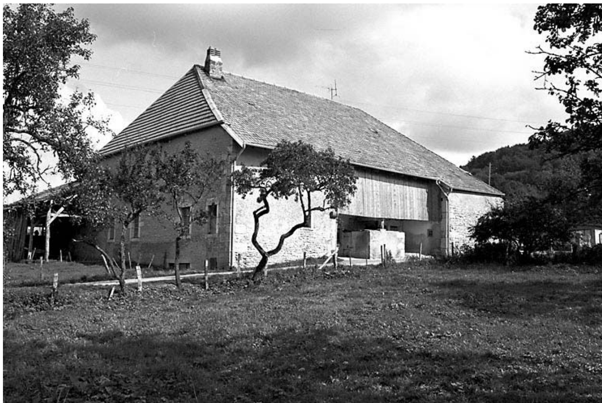
Façade postérieure et face latérale gauche.
