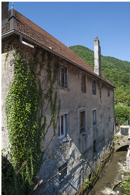
Façade nord du logement (ancien atelier). 25, Lods, 48 route de Besançon
