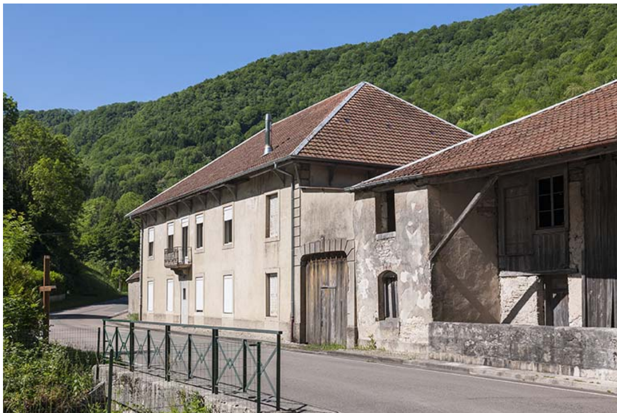
Logement patronal vu de trois quarts arrière. 25, Lods, 41 route de Besançon
