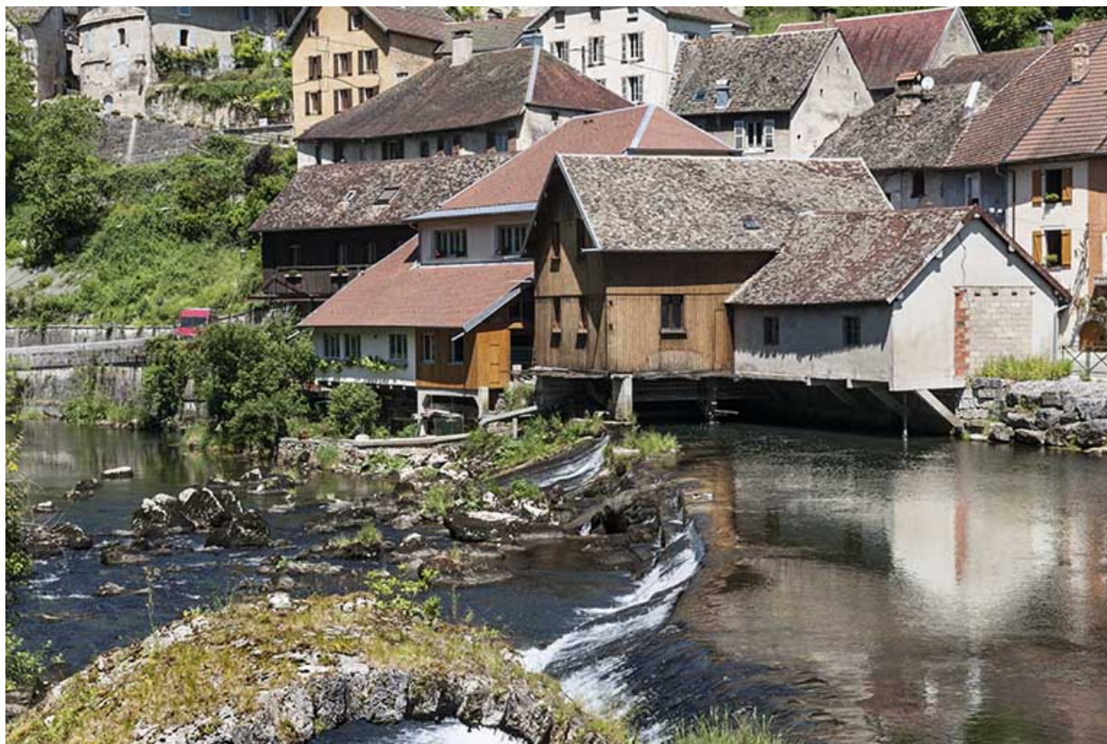
Vue depuis la tête amont du barrage.
