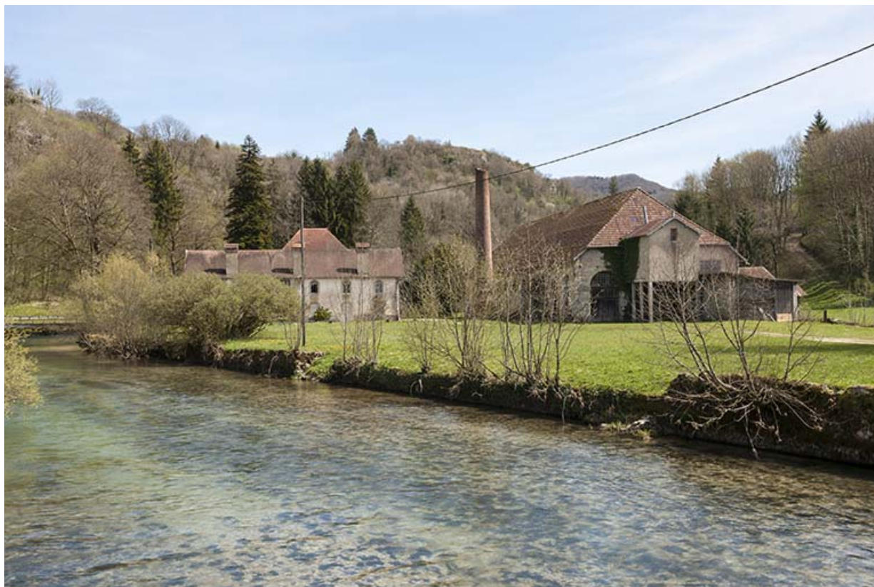
Vue d'ensemble depuis la rive droite de la Loue, à l'ouest.
