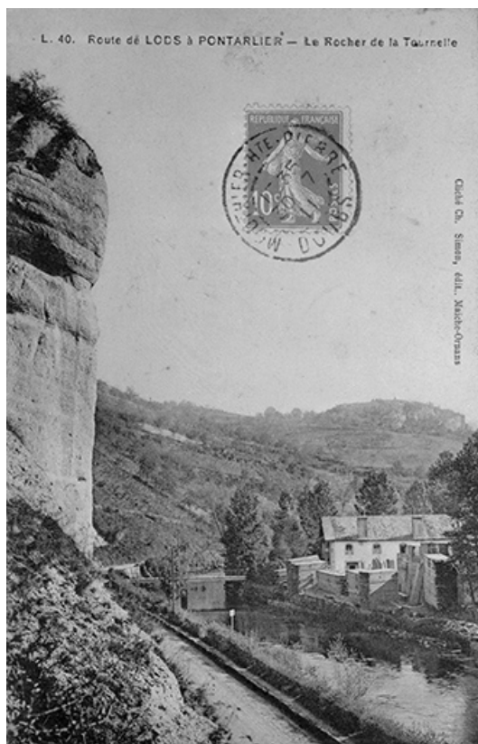
Route de Lods à Pontarlier. Le Rocher de la Tournelle, limite 19e siècle 20e siècle.
