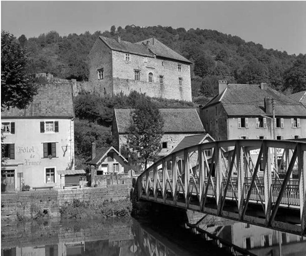
Vue générale depuis la rive gauche de la Loue.
