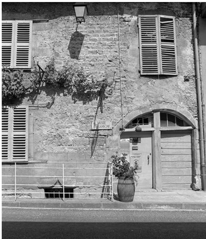
Détail de la façade antérieure : l'entrée.
