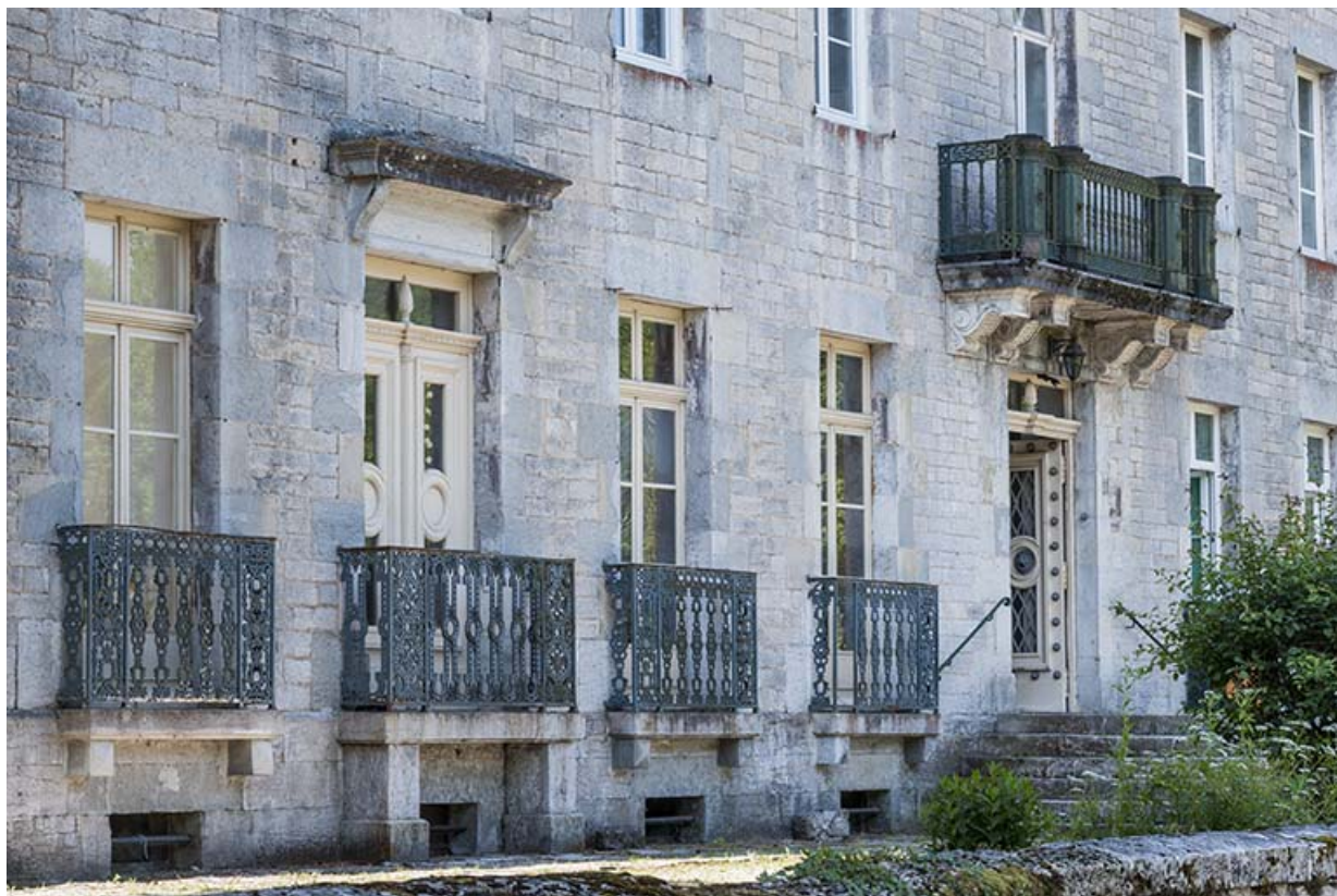
Détail de la façade du logement patronal.
