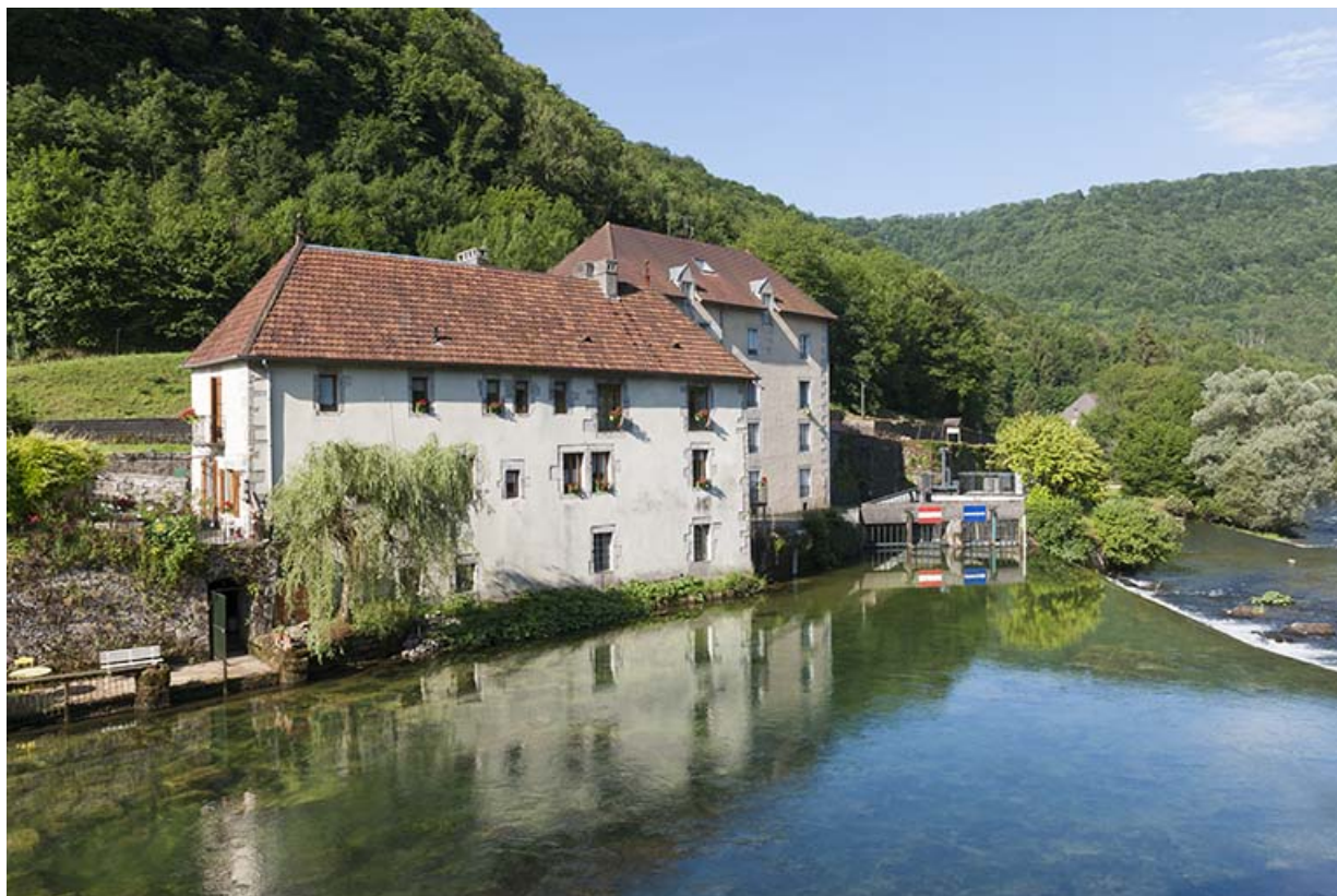
Logements d'ouvriers vus de trois quarts gauche.
