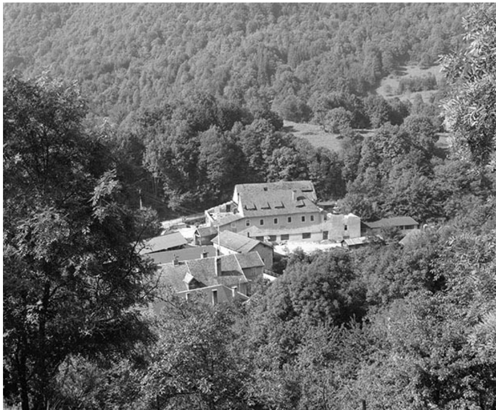
Vue d'ensemble du laminoir en destruction depuis le haut du village. 25, Lods chemin des Forges
