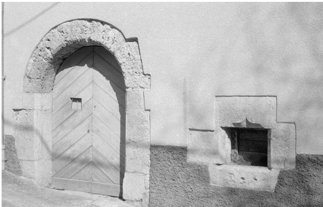
Maison située rue de Jaubourg, cadastrée 1971 AC 66 : encadrements des baies en tuf. 25, Lods
