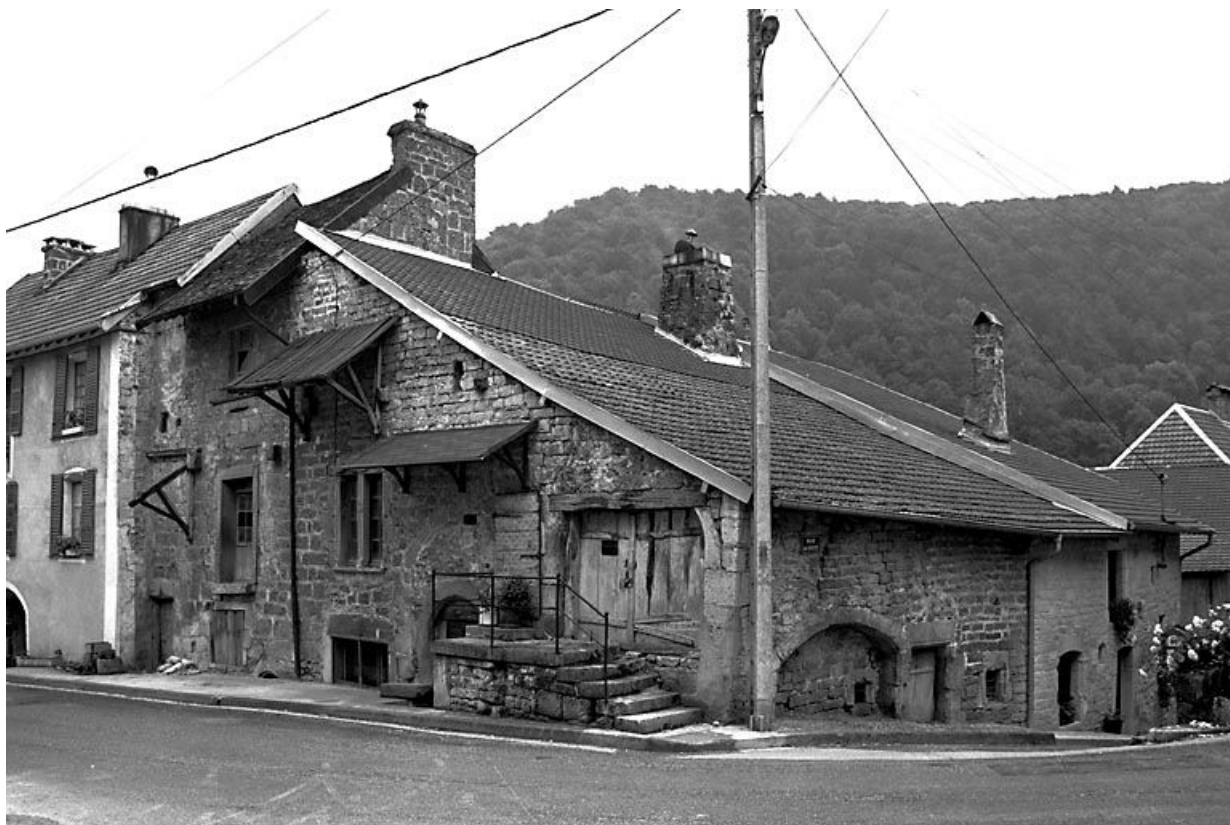
Façade antérieure et façade latérale droite. 25, Lods
