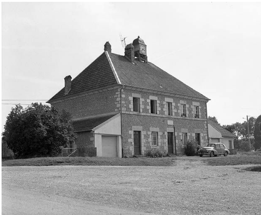
Façade postérieure et face latérale droite. 25, Foucherans rue de la Bascule
