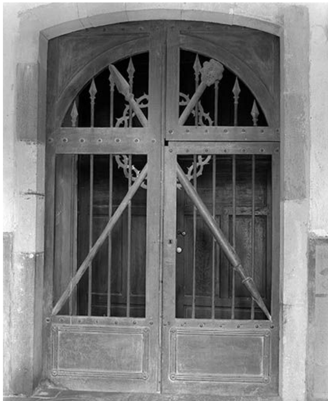
Porte conduisant à la nef.
