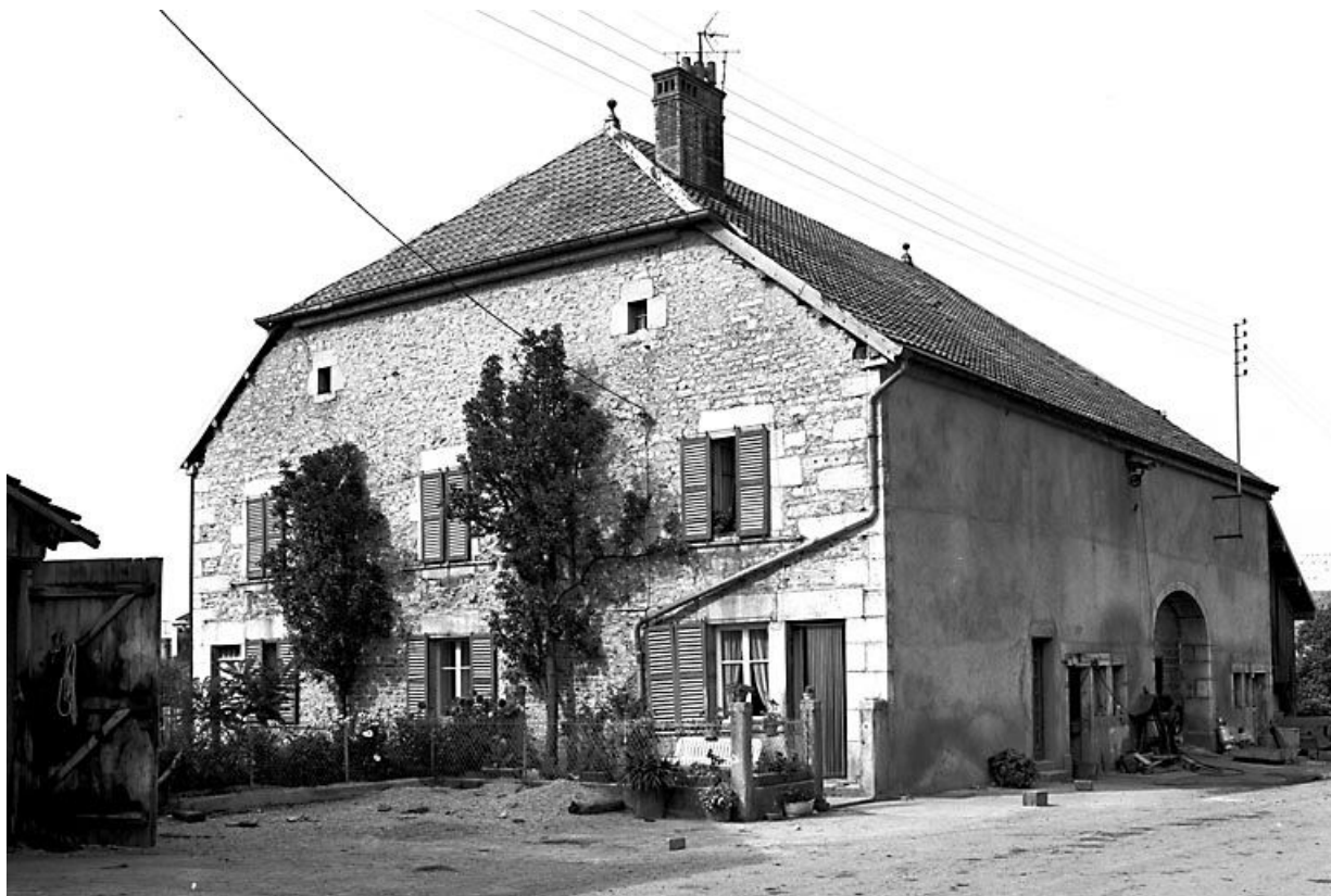
Façade antérieure et face latérale droite. 25, Chantrans
