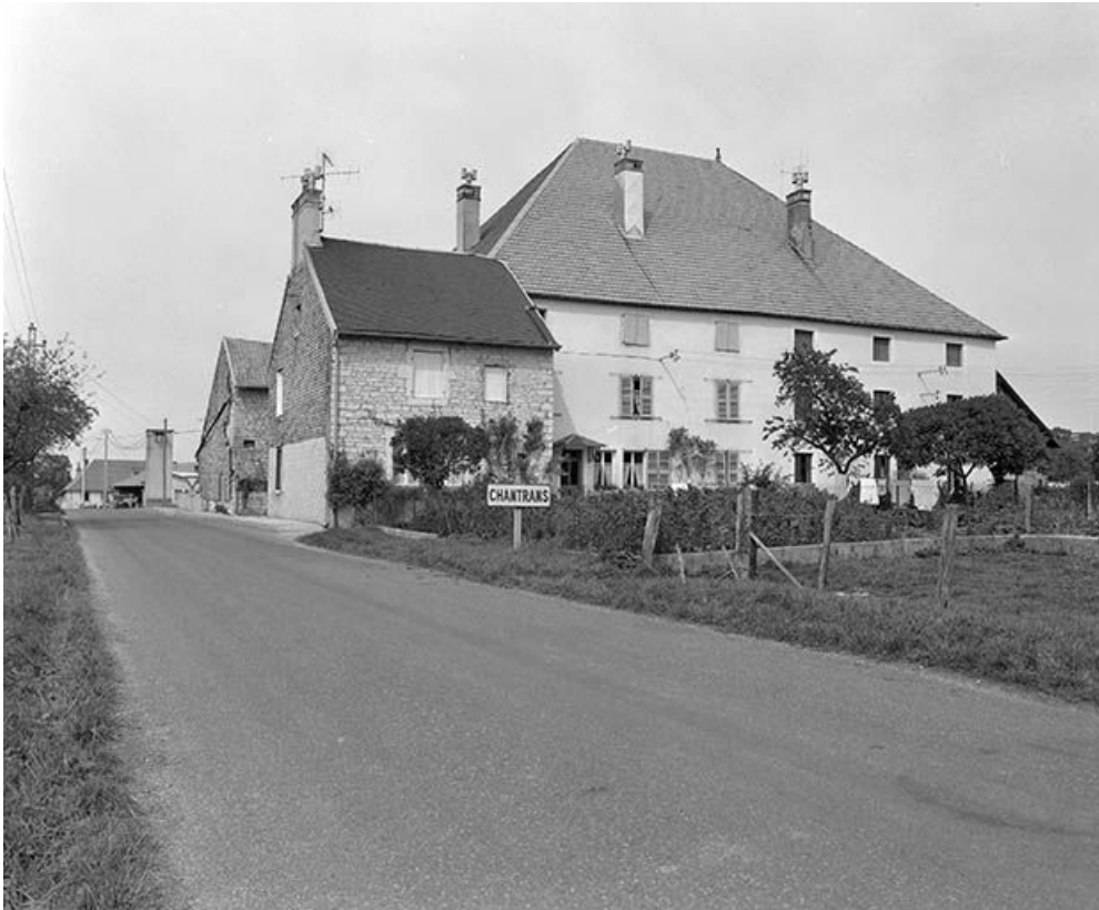
Vue d'ensemble depuis la RN 492. 25, Chantrains
