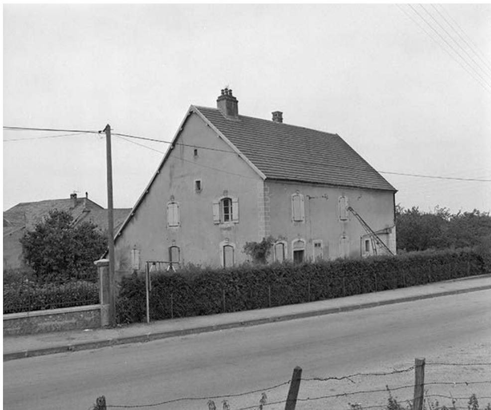
Façade antérieure et face latérale gauche. 25, Chantrains
