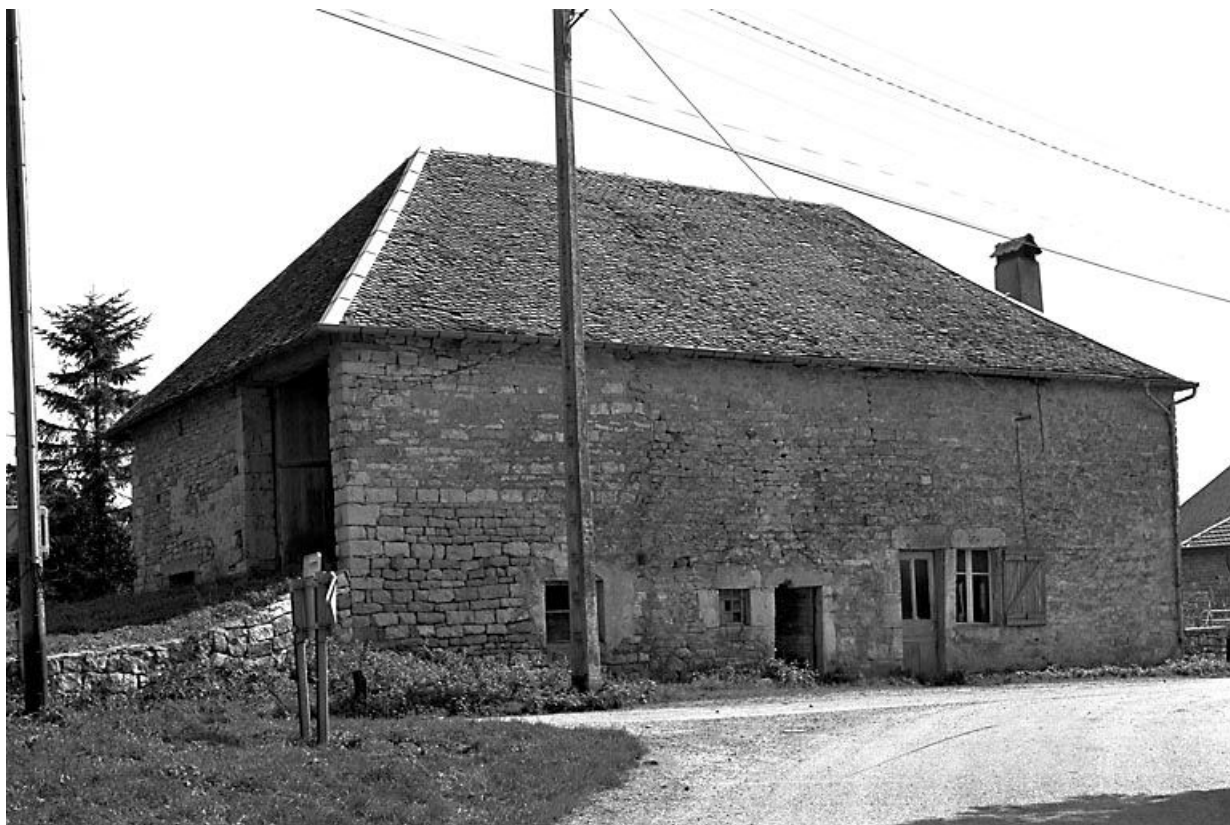
Façade antérieure vue de trois quarts gauche.
