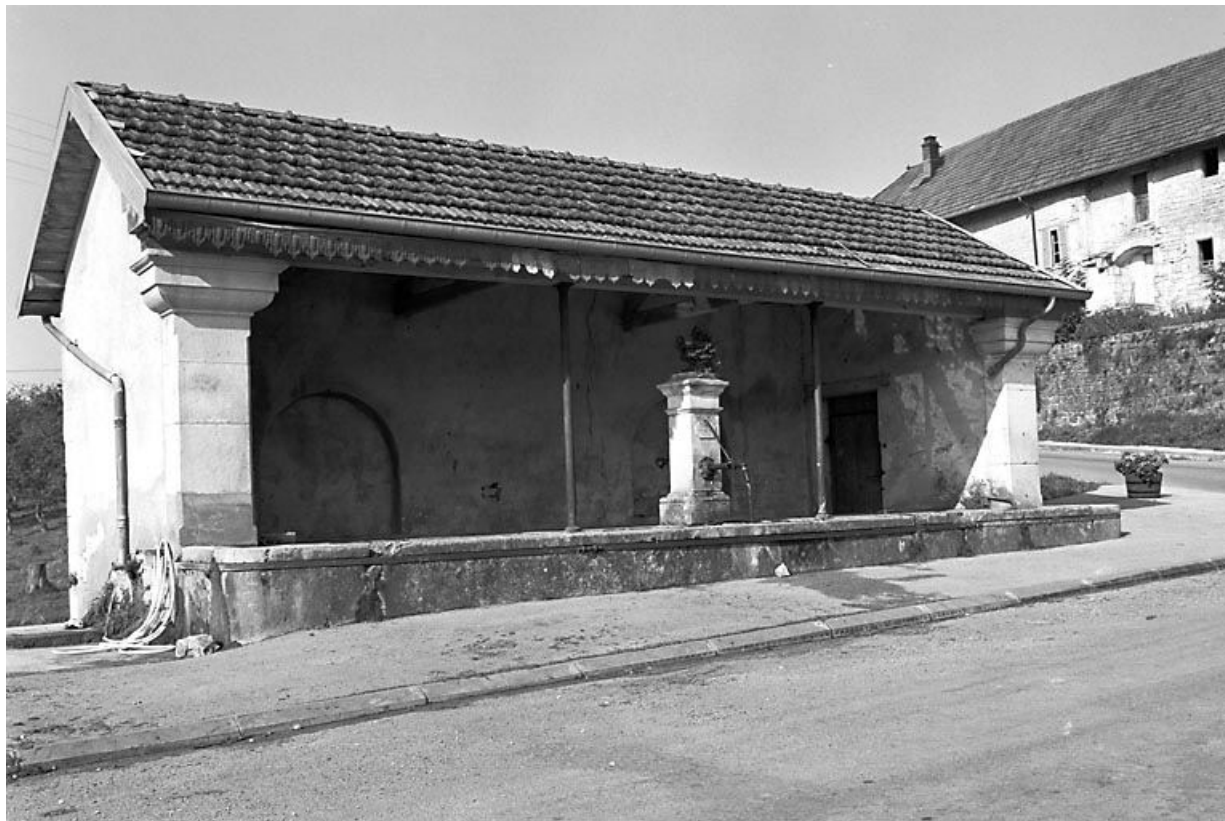
Vue générale de trois quarts gauche. 25, Amathay-Vésigneux
