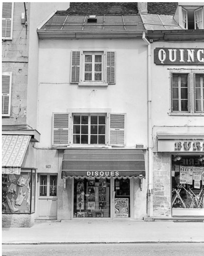
Façade sur rue, vue de face.
