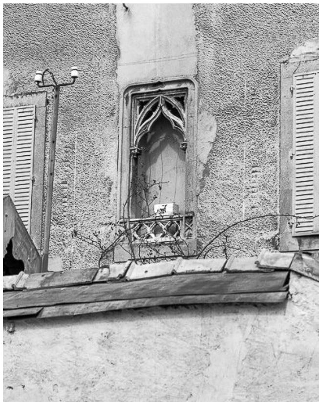
Fenêtre du pignon gauche.
