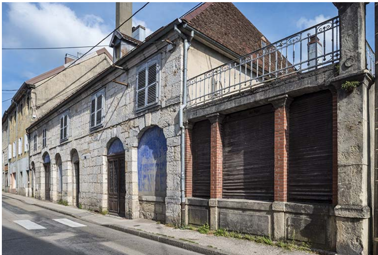
Vue rapprochée depuis le sud-ouest.
