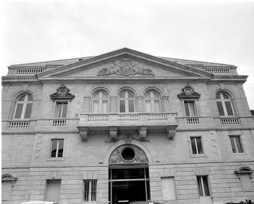
Façade antérieure. Corps central, vue d'ensemble.
