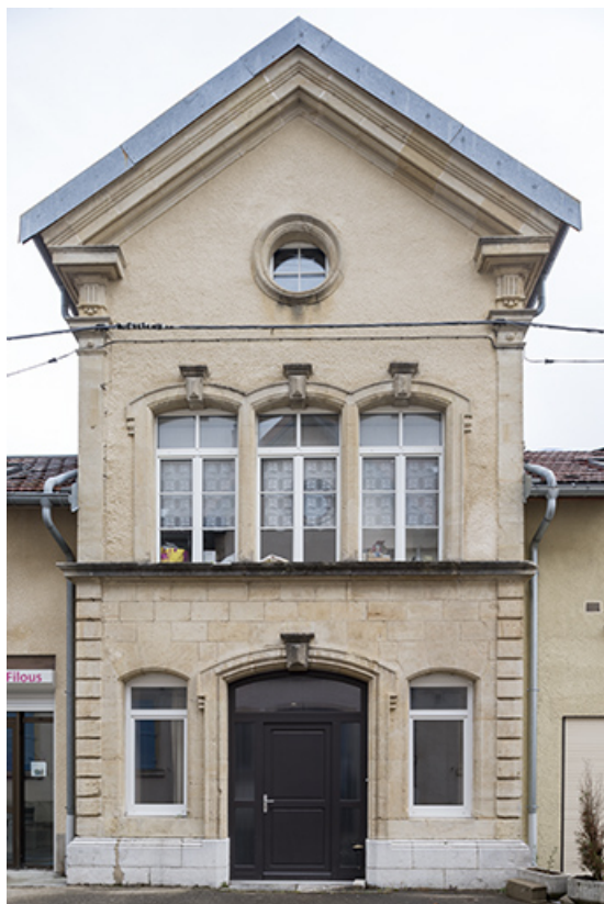
Façade ouest du pavillon central.
