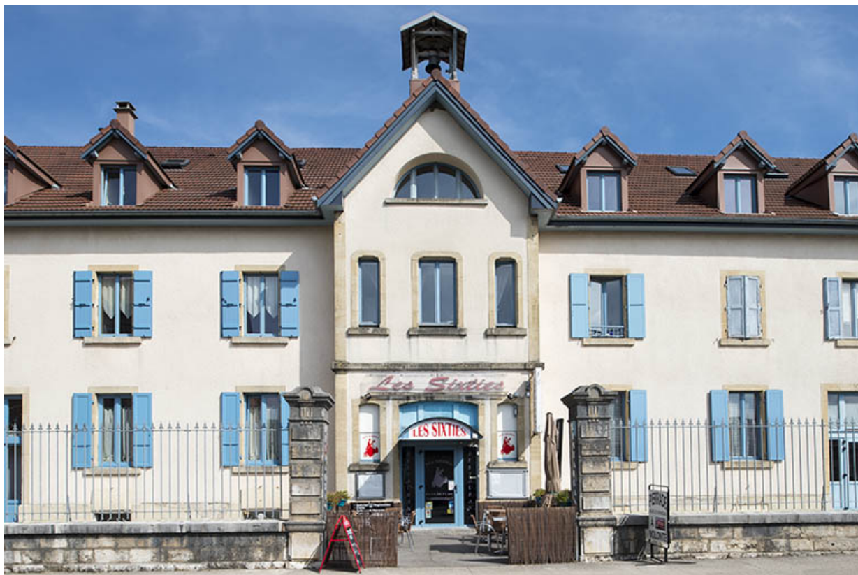
Partie centrale du bâtiment de la distillerie.
