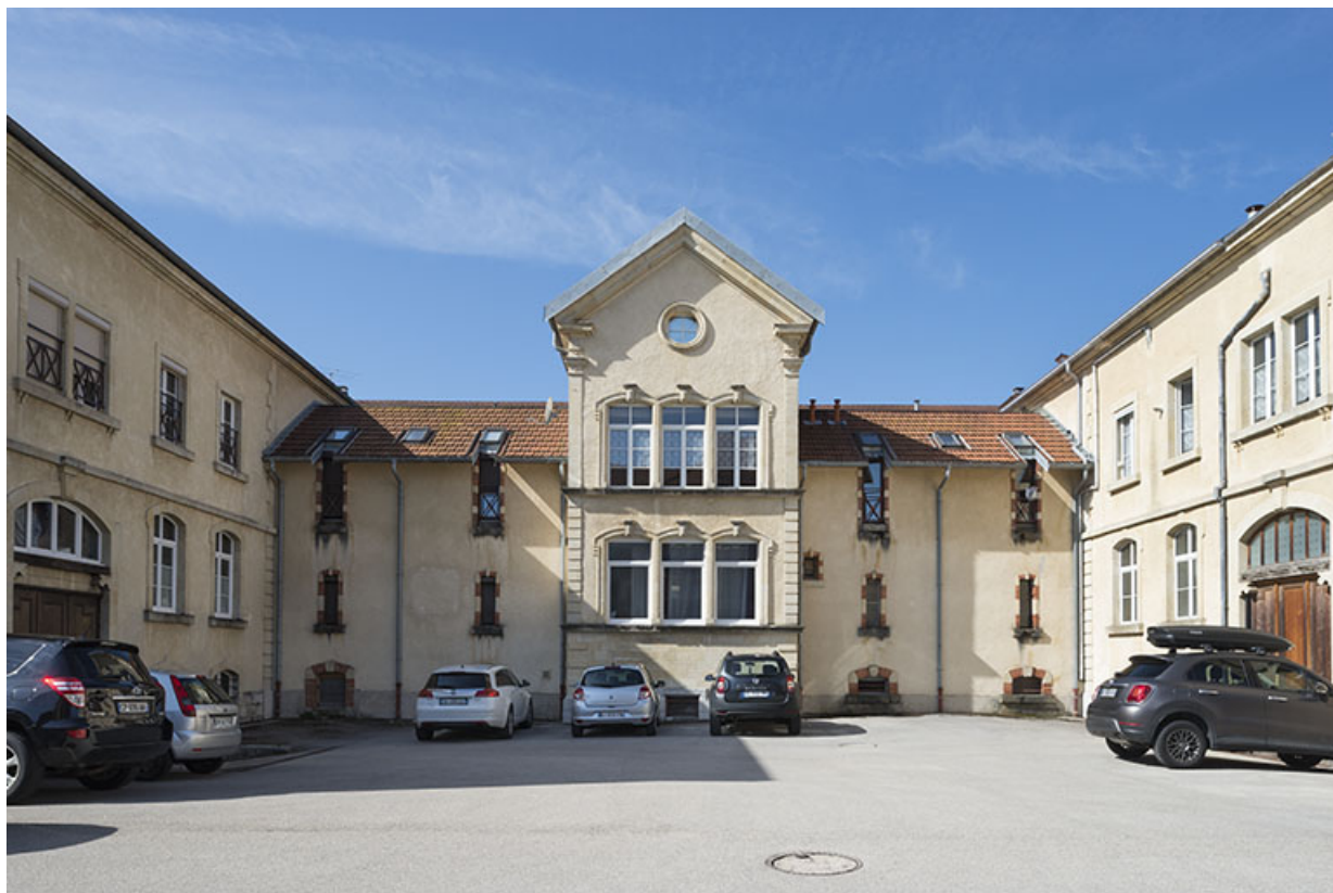
Vue axiale depuis la cour nord.
