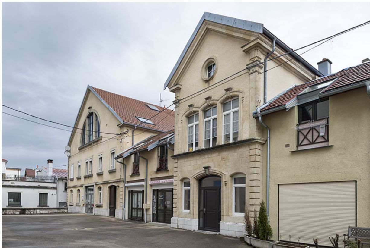
Façade des chais et entrepôts. Vue partielle. 25, Pontarlier, 34-36 rue de Besançon
