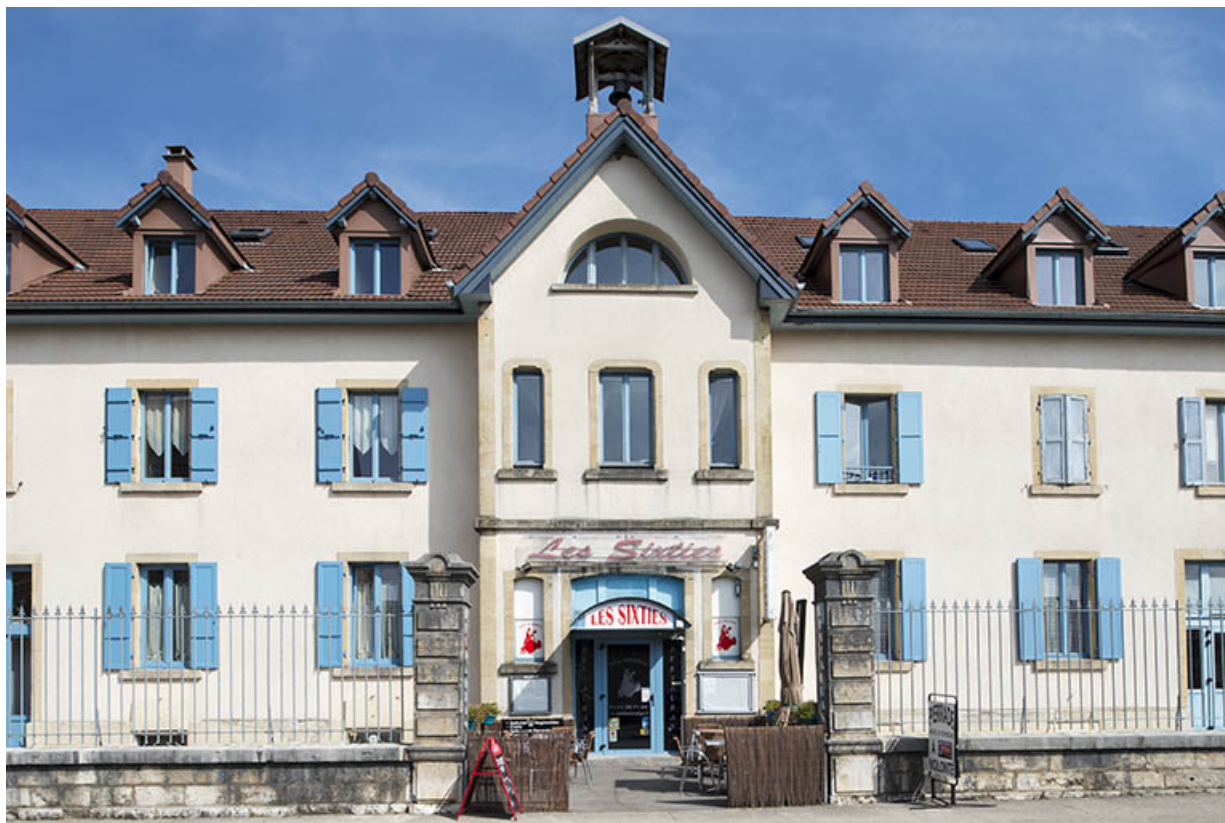
Partie centrale du bâtiment de la distillerie.
