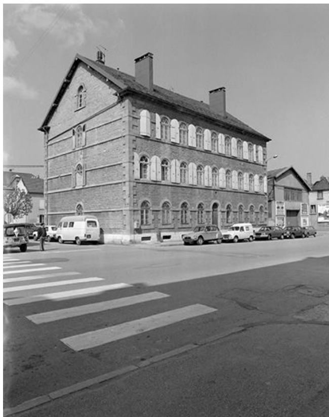
Façade sur rue, vue de trois quarts gauche.
