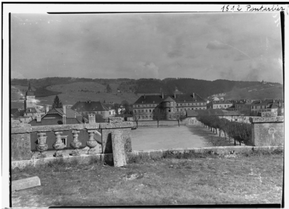
Façade sur la cour [1re moitié 20e siècle].
