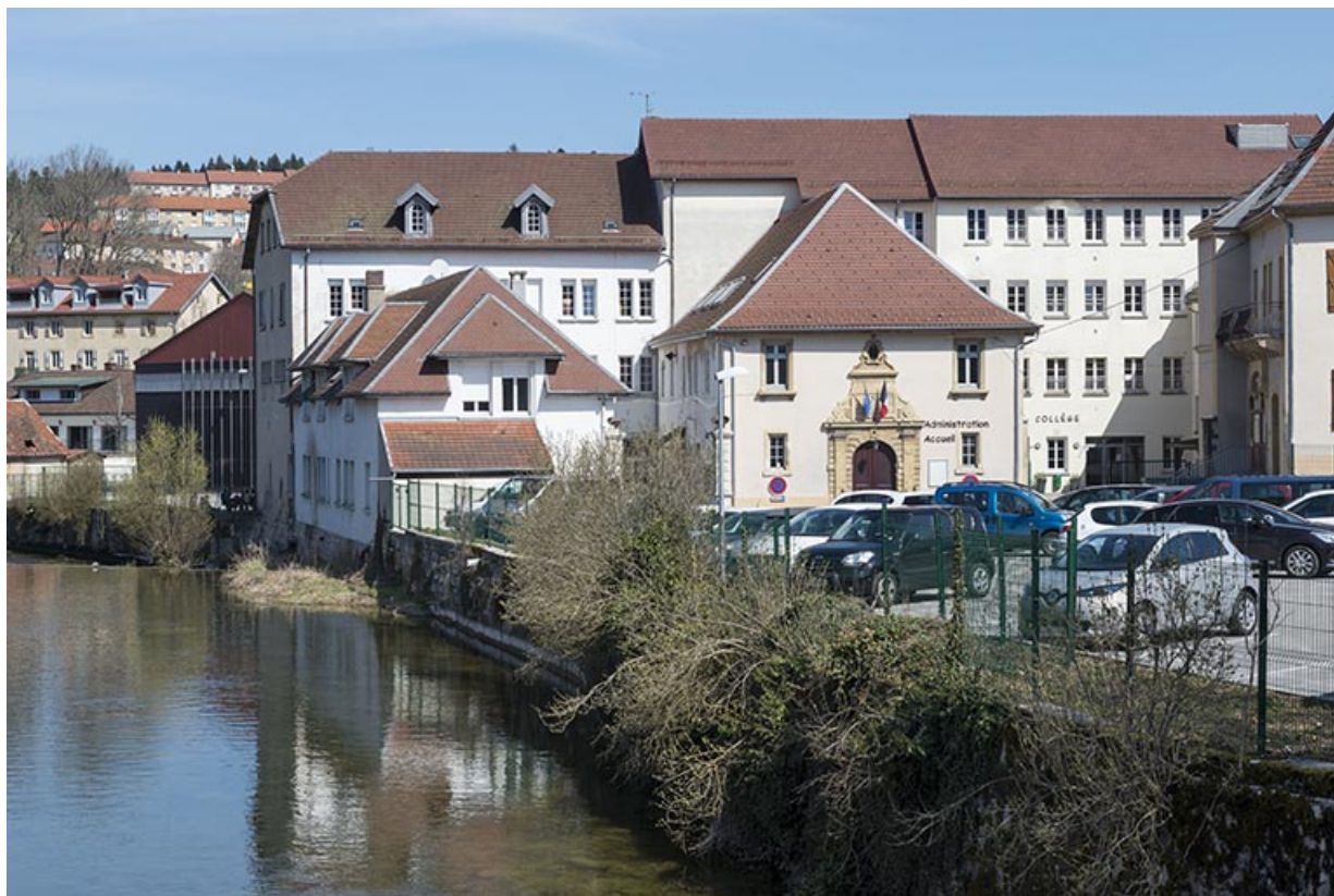
Vue rapprochée depuis le sud-ouest.
