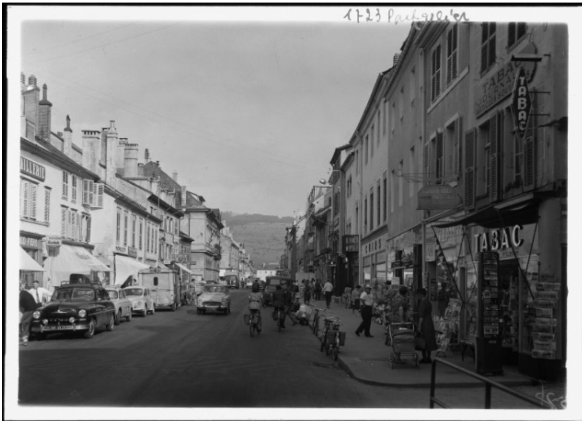
Rue de la République : vue à partir du n° 97, à l'opposé de la porte Saint-Pierre [1re moitié 20e siècle] 25, Pontarlier
