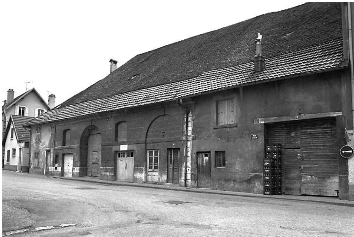
Façade sur rue. 25, Pontarlier
