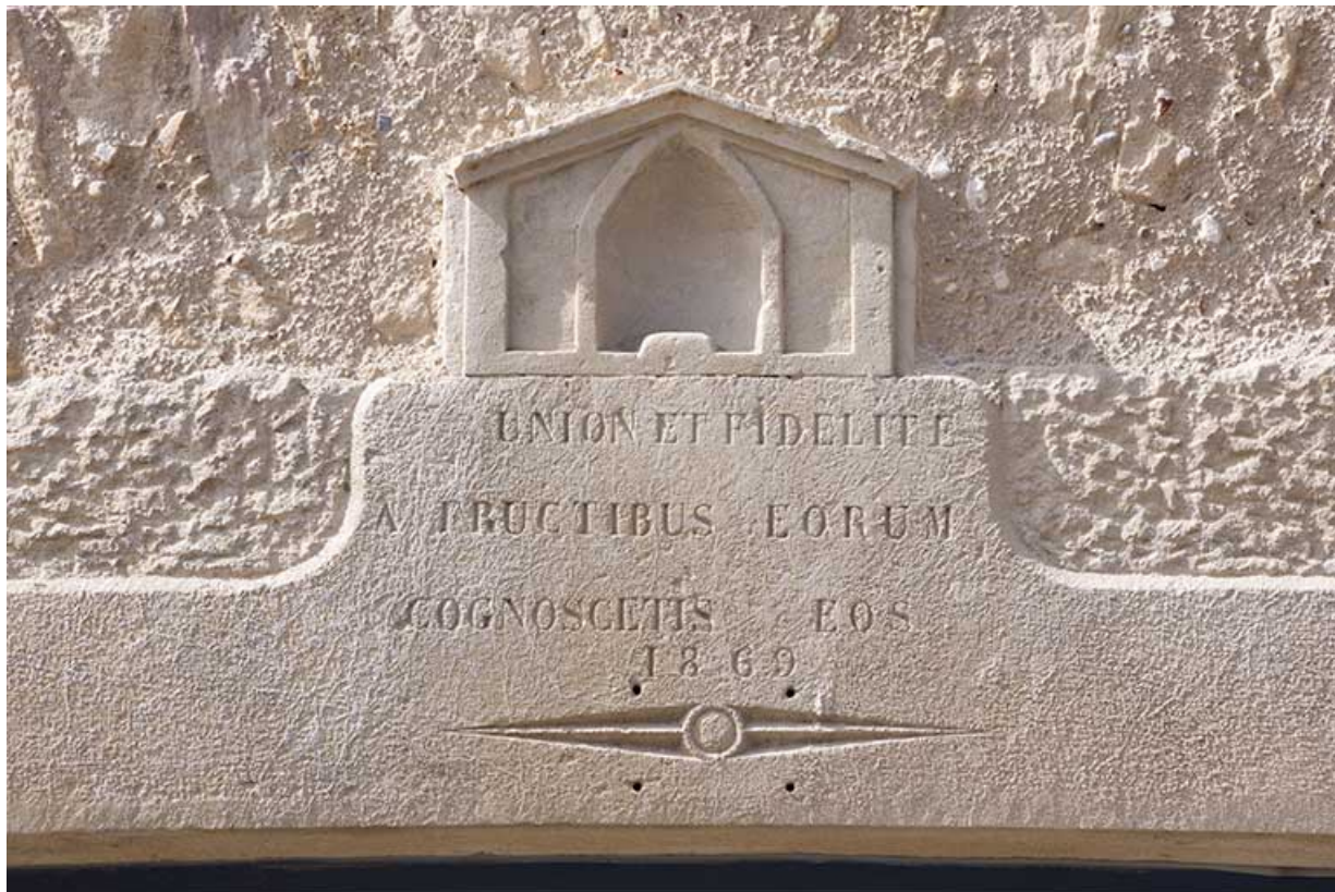
Mur-pignon est. Détail du linteau.
