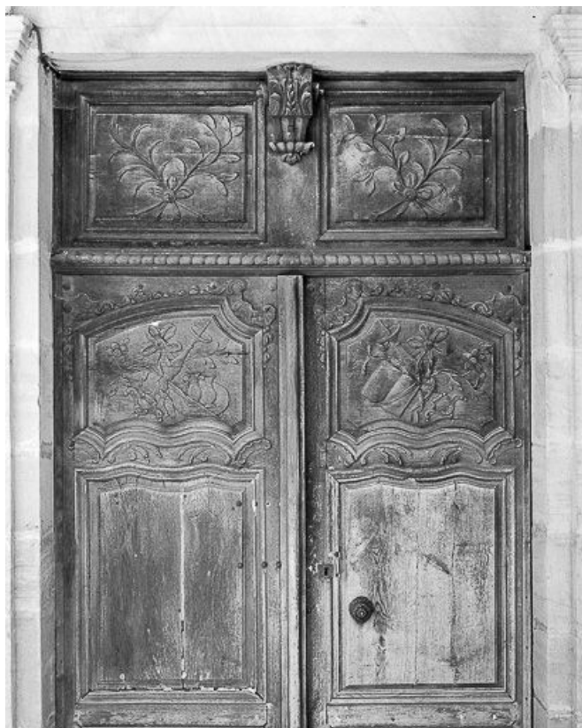
Vue d'ensemble de la deuxième porte d'entrée.
